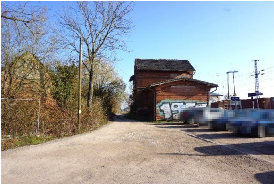
Bild 3: Nachbarschaft in östlicher Richtung, Bahnhofsgebäude Angern-Rogätz
