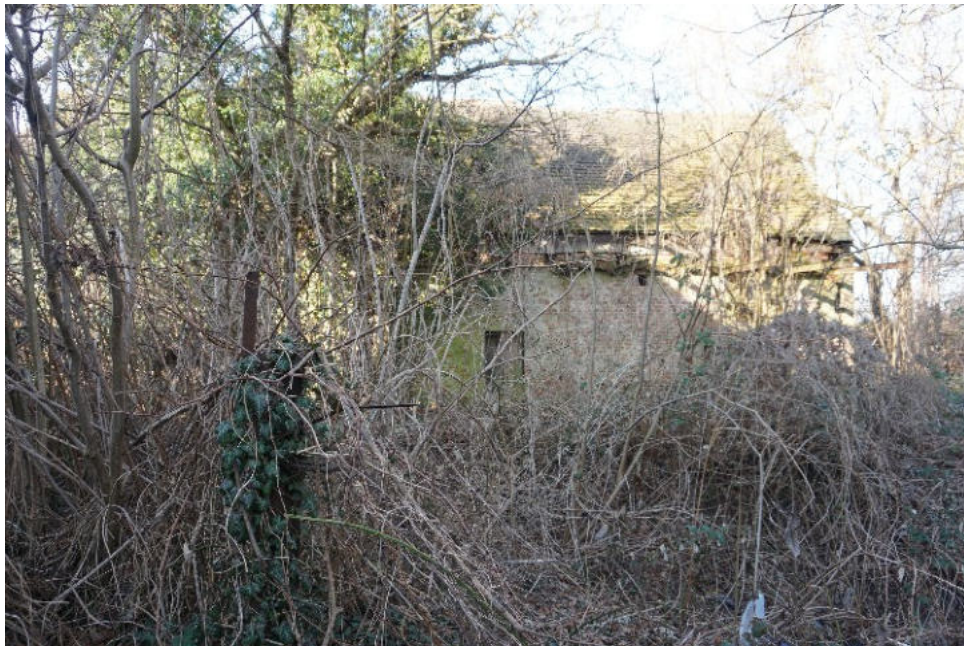
Bild 7: rückwärtiger Grundstücksbereich, stark verwildert und nicht zugänglich
