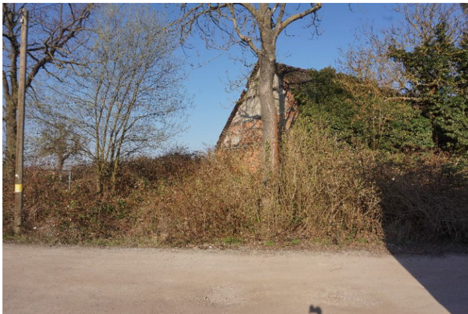
Bild 6: Ansicht des Bewertungsgrundstücks aus östlicher Richtung
