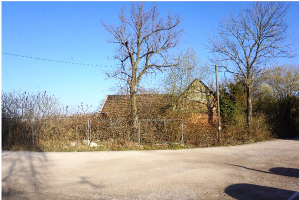
Bild 5: Ansicht des Bewertungsgrundstücks aus östlicher Richtung
