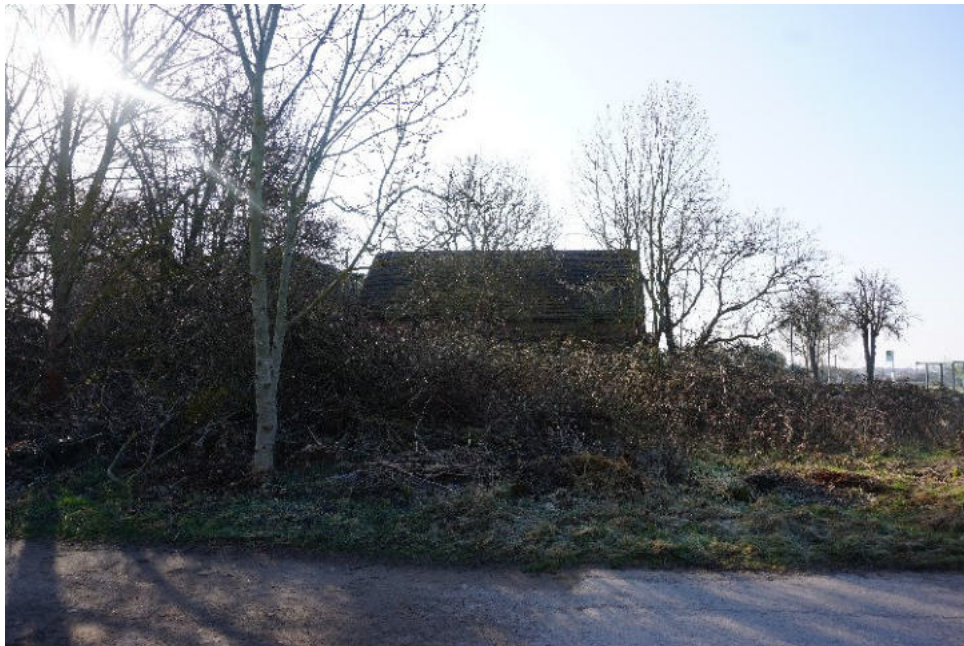
Bild 13: Ansicht des Bewertungsgrundstücks aus nördlicher Richtung
