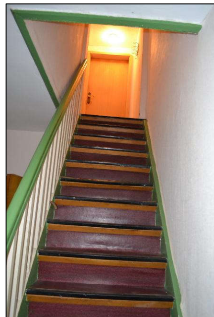
Bild 54: Treppe zum DG (ausgebauter Bereich)
