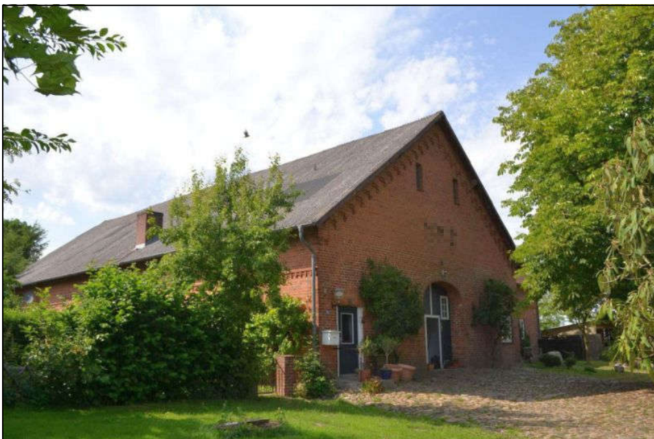
Bild 2: Südostansicht des Wohn- und Wirtschaftsgebäudes
