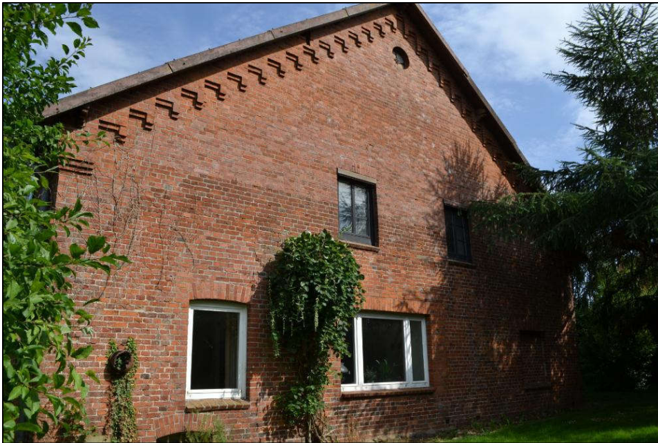
Bild 9: West(teil)ansicht des Wohn- und Wirtschaftsgebäudes
