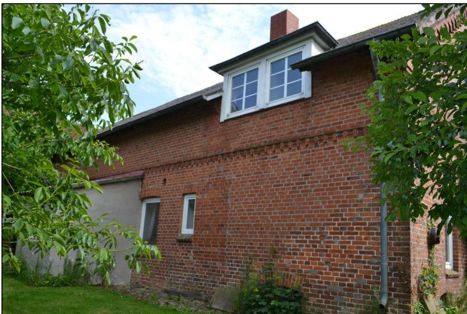
Bild 8: Nordwest(teil)ansicht des Wohn- und Wirtschaftsgebäudes
