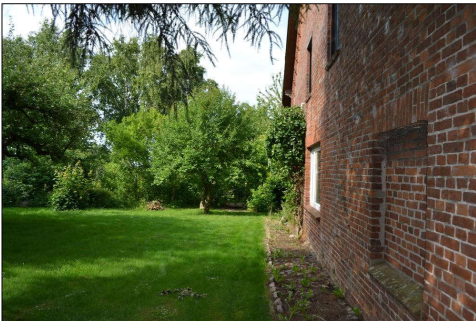
Bild 18: Blick entlang der Gebäudewestseite nach Norden
