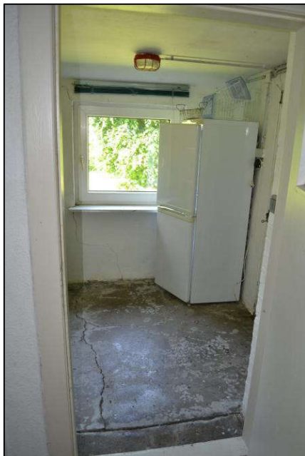
Bild 49: Windfanganbau vor der Küche
