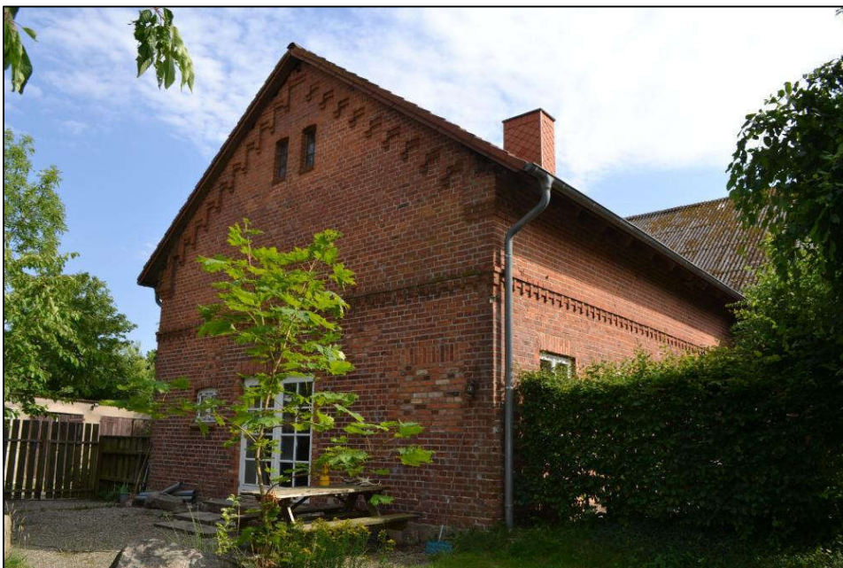
Bild 6: Nordwest(teil)ansicht des Wohn- und Wirtschaftsgebäudes
