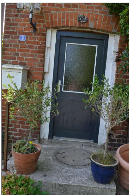
Bild 29: Eingangstür zum Partyraum (Ostseite)
