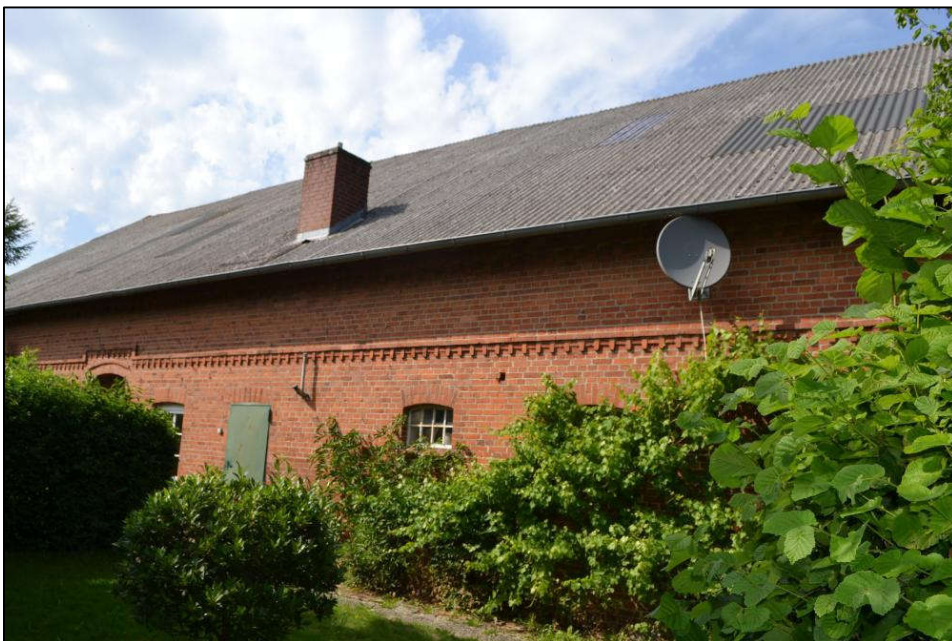
Bild 10: Süd(teil)ansicht des Wohn- und Wirtschaftsgebäudes
