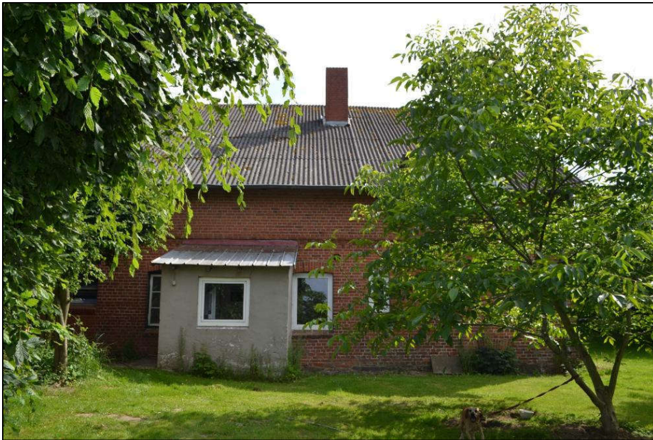
Bild 7: Nord(teil)ansicht des Wohn- und Wirtschaftsgebäudes
