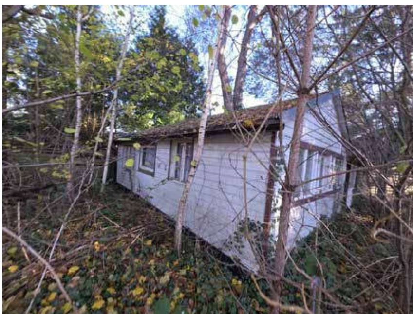
Bild 2: Gartenhaus, westliche Gebäudeecke
