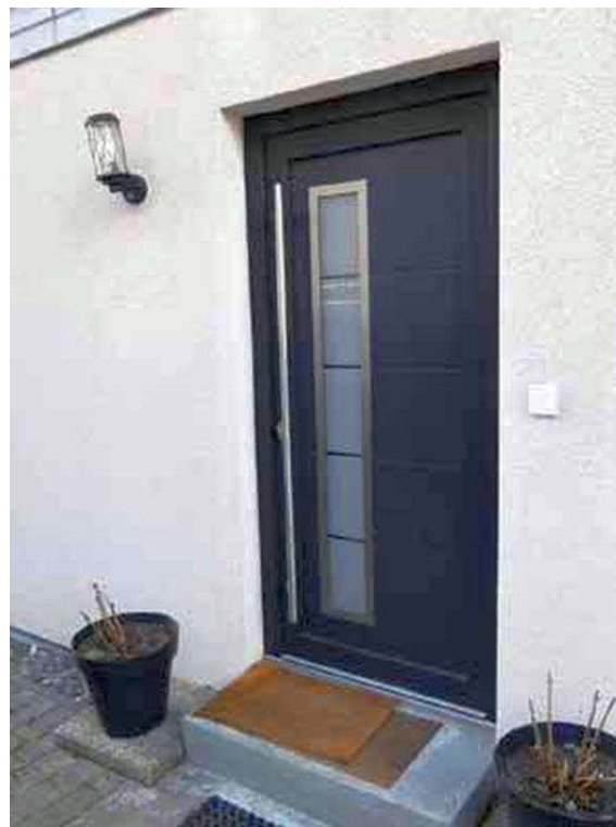
Bild 6: Hauseingangstür des Einfamilienhauses
