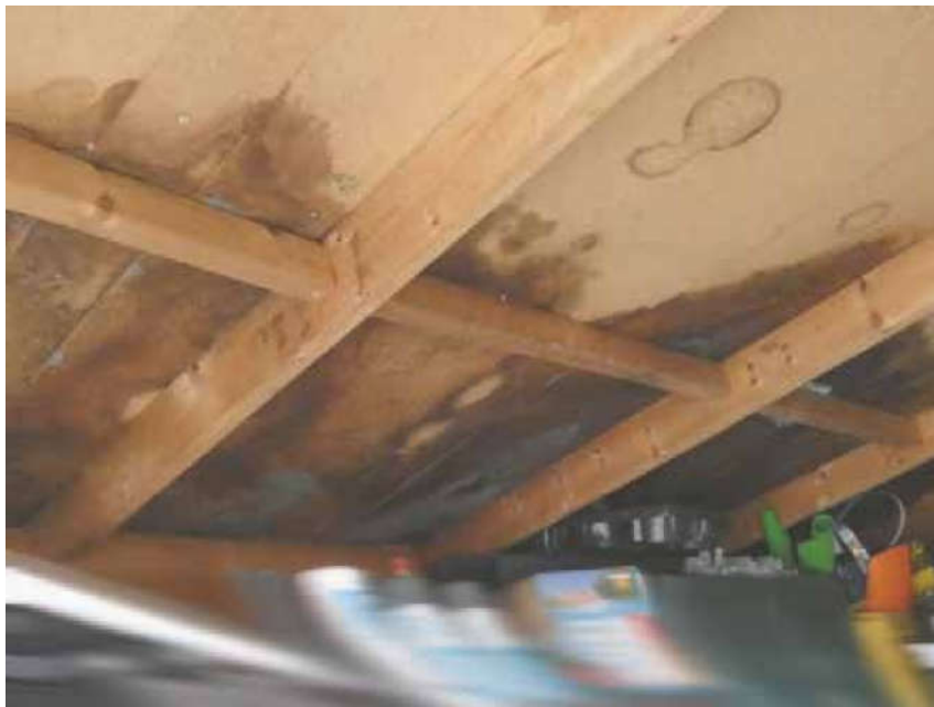
Bild 15: Detailansicht vom Dach des Geräteschuppens (innen)
