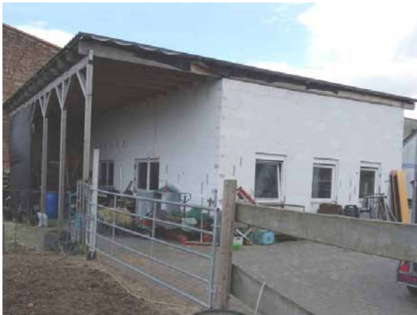
Bild 12: Doppelgarage mit Überdachung an der Rückseite
