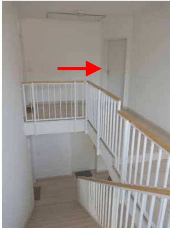
Bild 5: Treppenhaus des Hauses E, mit Eingang zur Wohnung Nr. 33
