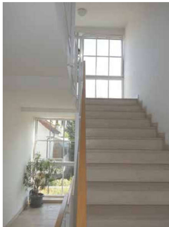
Bild 4: Treppenhaus des Hauses E
