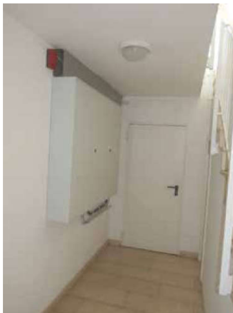
Bild 16: Kellergang im Haus Berliner Straße 20a
