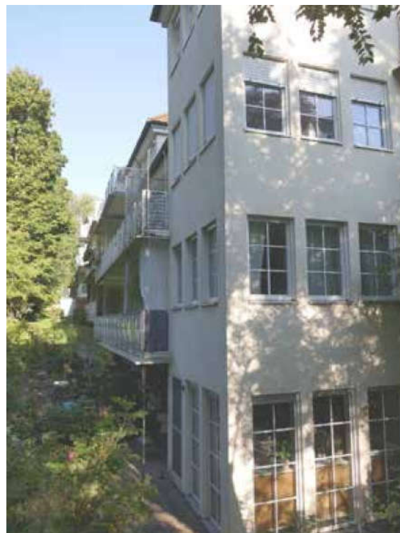
Bild 20: Blick entlang der Südwestseite der Häuser E und D
