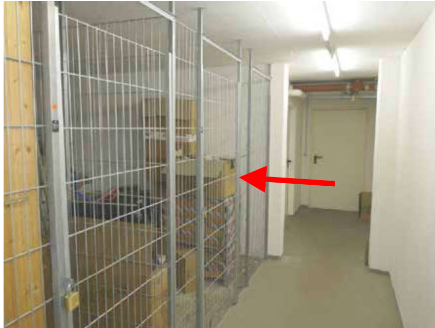
Bild 7: Kellergang des Hauses E, mit Keller 33
