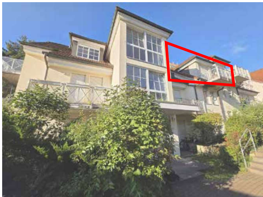
Bild 2: Ansicht der Häuser E und D vom Hof aus, mit Kennzeichnung der Lage des Bewertungsobjekts
