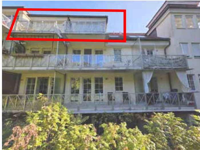
Bild 3: Ansicht der Häuser E und D aus südwestlicher Richtung, mit Kennzeichnung der Lage des Bewertungsobjekts
