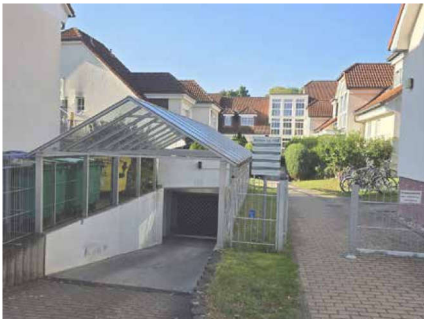
Bild 12: Einfahrt zur Tiefgarage, Zugang zu den straßenabseitig stehenden Gebäuden
