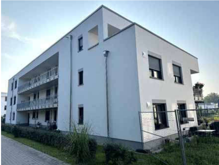
Bild 3: Straßenansicht Gebäude Karl-Marx-Straße 62 (Haus G)
