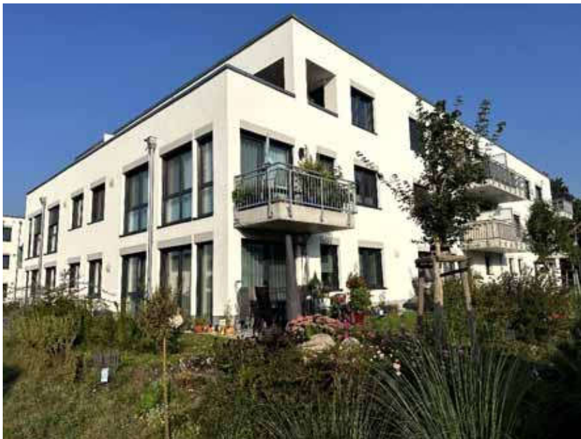
Bild 4: Seiten-/Rückansicht Gebäude Karl-Marx-Straße 62 (Haus G)
