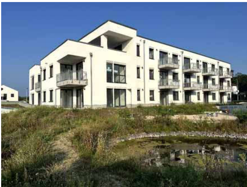
Bild 2: Seiten-/Rückansicht Gebäude Lilienthal-Straße 2 (Haus F)
