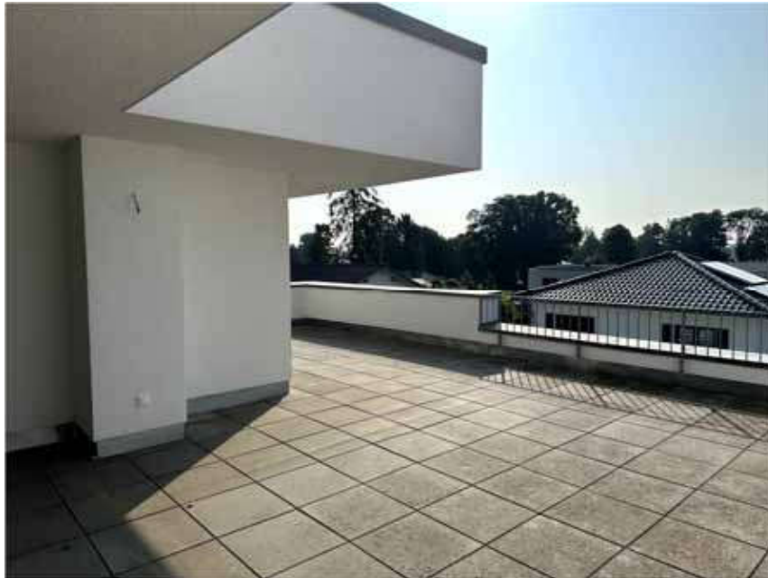
Bild 21: Dachterrasse, WE Nr. 54
