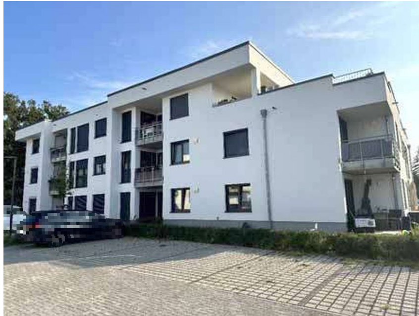
Bild 5: Seiten/Rückansicht Gebäude Alte Werftstraße 1 (Haus H)
