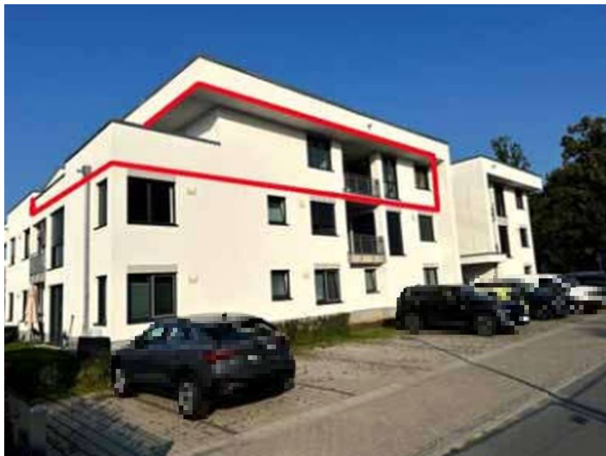
Bild 6: Seiten/Vorderansicht Gebäude Alte Werftstraße 1 (Haus H) mit Kennzeichnung WE Nr. 54
