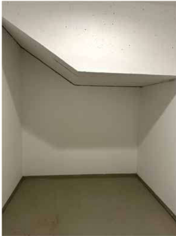
Bild 23: Abstellraum im EG, WE Nr. 54
