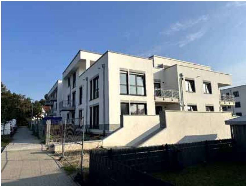
Bild 1: Straßen-/Seitenansicht Gebäude Lilienthal-Straße 2 (Haus F)
