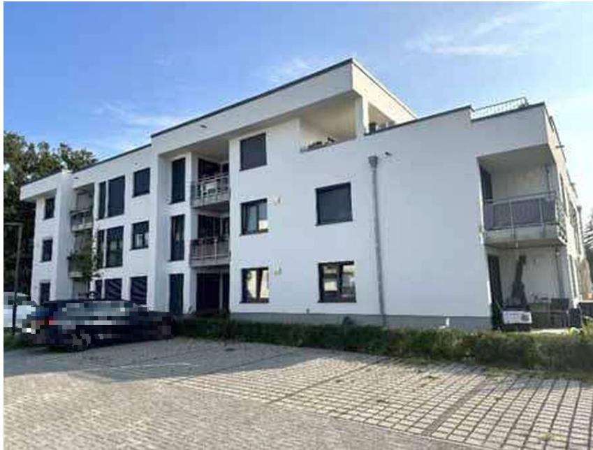
Bild 5: Seiten/Rückansicht Gebäude Alte Werftstraße 1 (Haus H)
