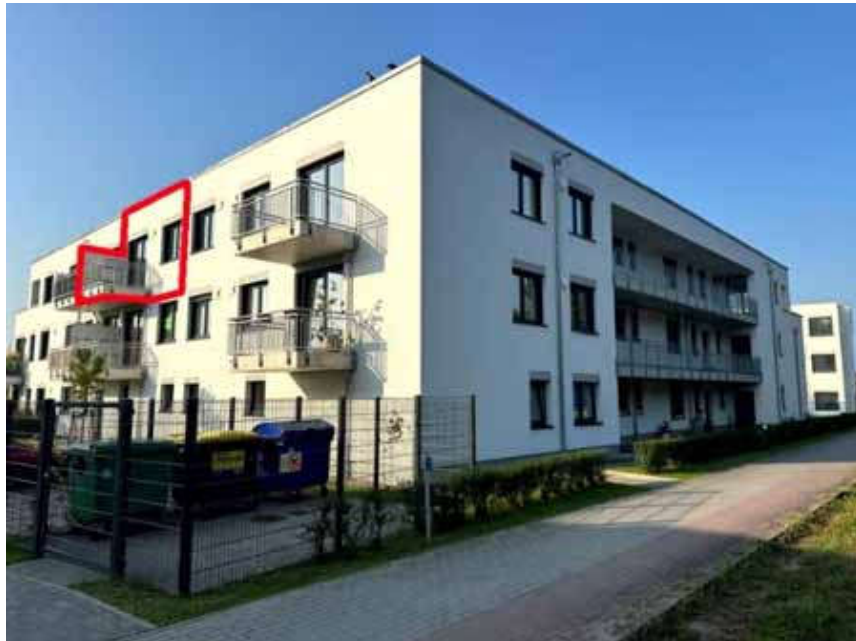
Bild 7: Straßenansicht Gebäude Karl-Marx-Straße 62 (Haus G) mit Kennzeichnung WE Nr. 39
