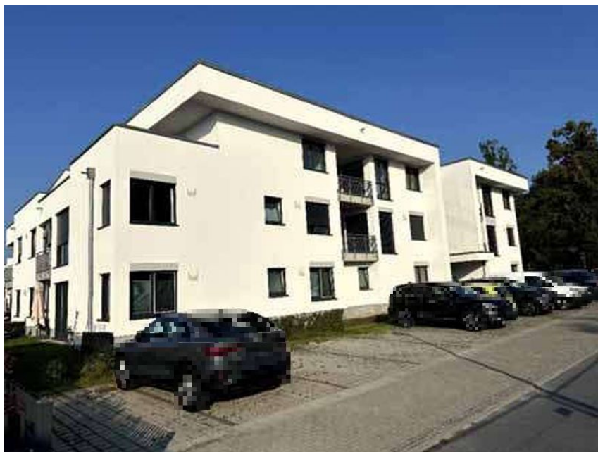
Bild 6: Seiten/Vorderansicht Gebäude Alte Werftstraße 1 (Haus H)
