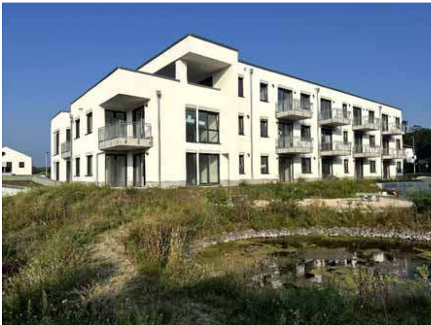
Bild 2: Seiten-/Rückansicht Gebäude Lilienthal-Straße 2 (Haus F)
