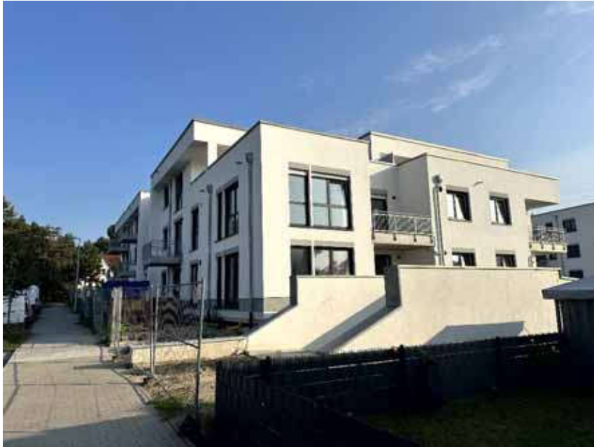
Bild 1: Straßen-/Seitenansicht Gebäude Lilienthal-Straße 2 (Haus F)
