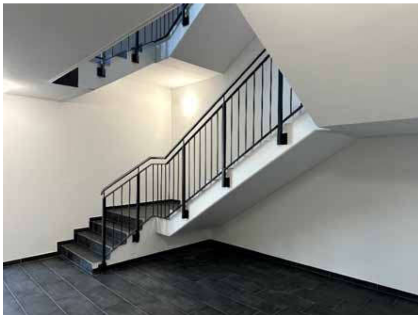
Bild 10: Treppenhaus Gebäude Karl-Marx-Straße 62 (Haus G)
