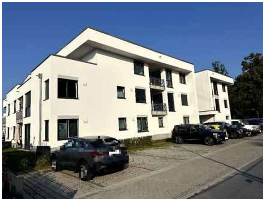
Bild 6: Seiten/Vorderansicht Gebäude Alte Werftstraße 1 (Haus H)
