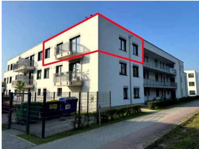
Bild 7: Straßenansicht Gebäude Karl-Marx-Straße 62 (Haus G) mit Kennzeichnung WE Nr. 38
