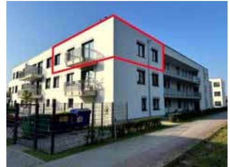
Straßenansicht Karl-Marx-Straße 62 (Haus G) mit Kennzeichnung Sondereigentum WE Nr. 38
