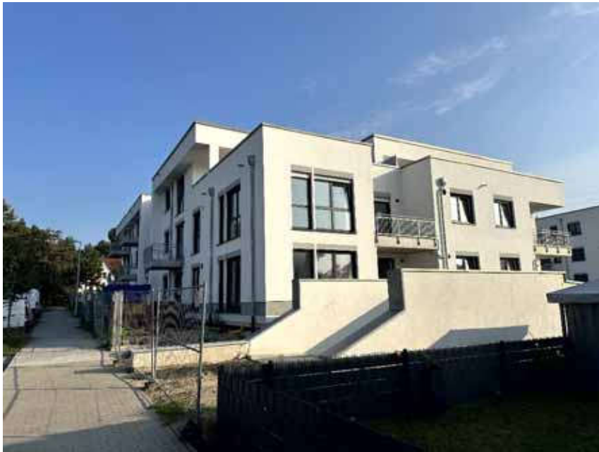
Bild 1: Straßen-/Seitenansicht Gebäude Lilienthal-Straße 2 (Haus F)
