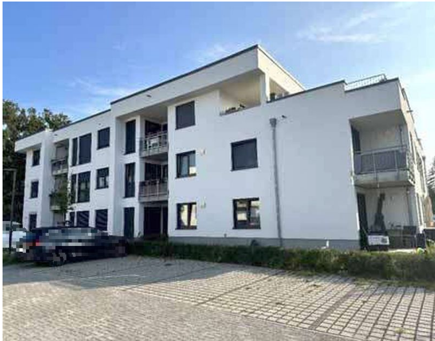
Bild 5: Seiten/Rückansicht Gebäude Alte Werftstraße 1 (Haus H)
