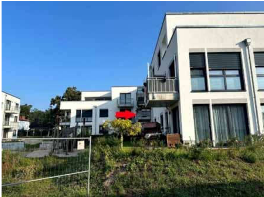
Bild 7: Rückansicht Gebäude Karl-Marx-Straße 62 (Haus G) mit Kennzeichnung der Lage der WE Nr. 35 (Pfeil zeigt auf den Balkon des Sondereigentums)
