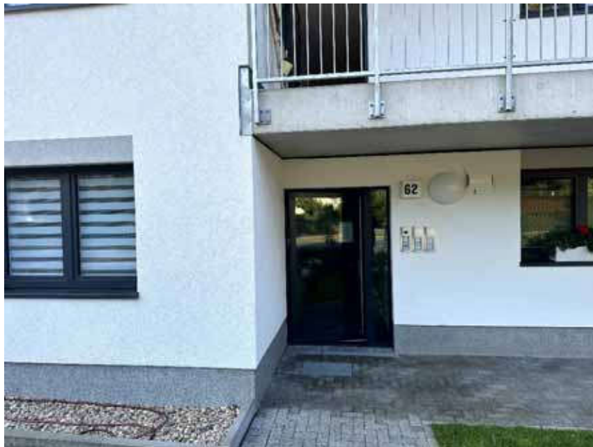
Bild 8: Hauseingang Gebäude Karl-Marx-Straße 62 (Haus G)
