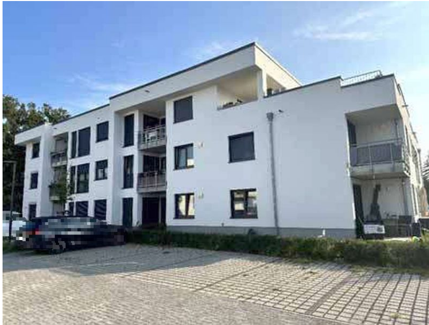
Bild 5: Seiten/Rückansicht Gebäude Alte Werftstraße 1 (Haus H)
