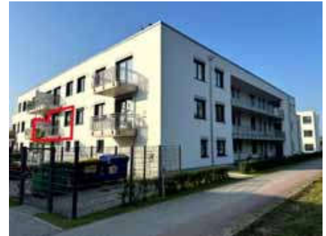
Straßenansicht, Karl-Marx-Straße 62 (Haus G) mit Kennzeichnung Son- dereigentum WE Nr. 30
