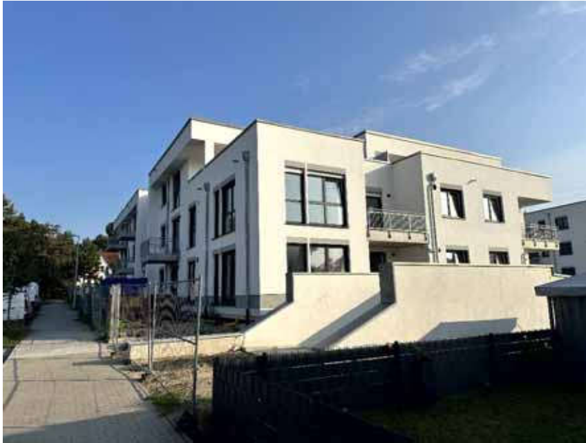
Bild 1: Straßen-/Seitenansicht Gebäude Lilienthal-Straße 2 (Haus F)
