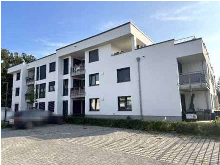
Bild 5: Seiten/Rückansicht Gebäude Alte Werftstraße 1 (Haus H)
