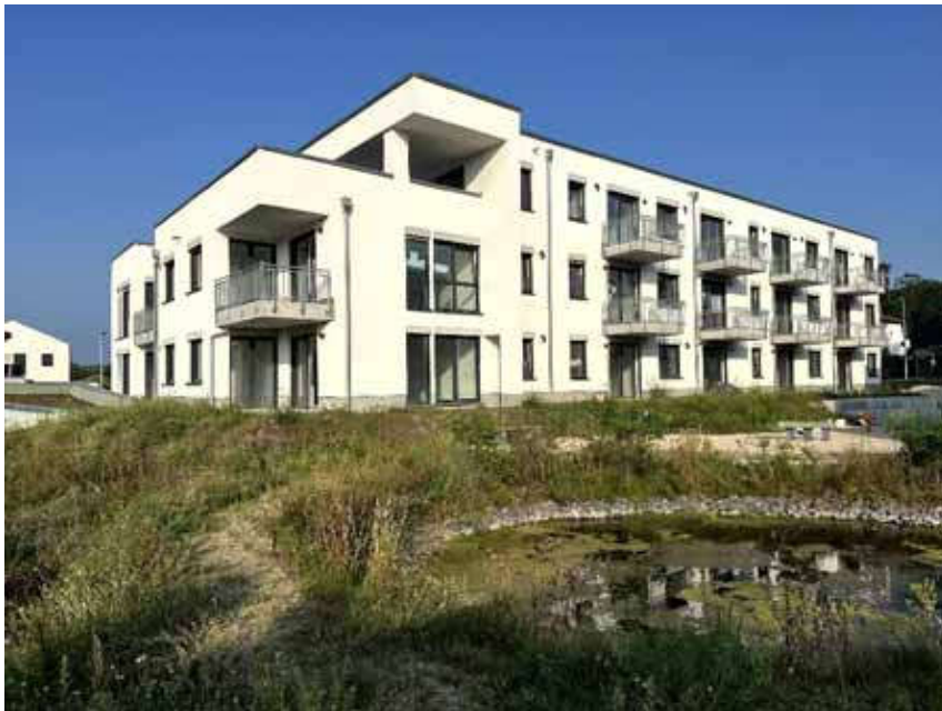
Bild 2: Seiten-/Rückansicht Gebäude Lilienthal-Straße 2 (Haus F)
