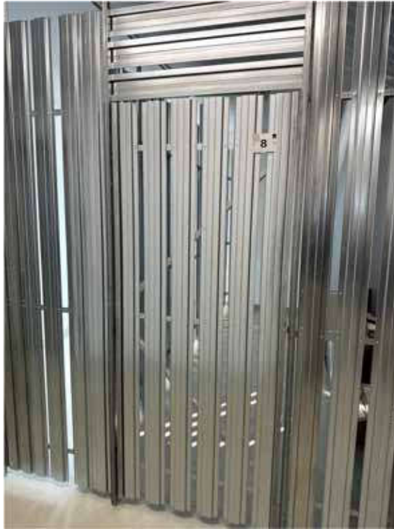
Bild 19: Abstellraum im EG, WE Nr. 30
