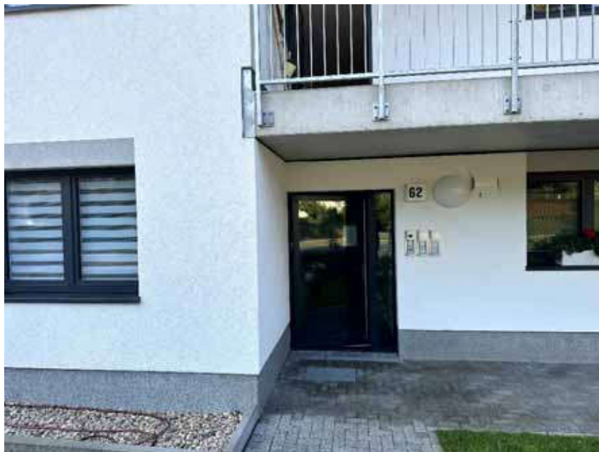
Bild 8: Hauseingang Gebäude Karl-Marx-Straße 62 (Haus G)
