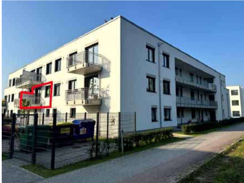
Bild 7: Straßenansicht Gebäude Karl-Marx-Straße 62 (Haus G) mit Kennzeichnung WE Nr. 30
