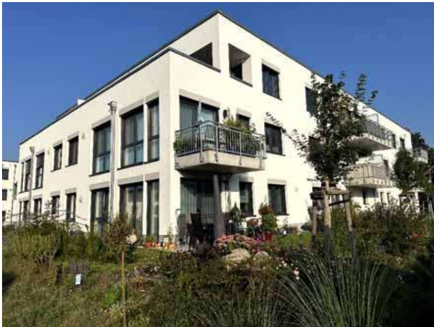
Bild 4: Seiten-/Rückansicht Gebäude Karl-Marx-Straße 62 (Haus G)
