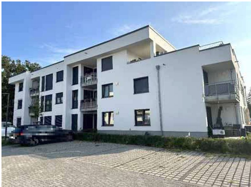
Bild 5: Seiten/Rückansicht Gebäude Alte Werftstraße 1 (Haus H)
