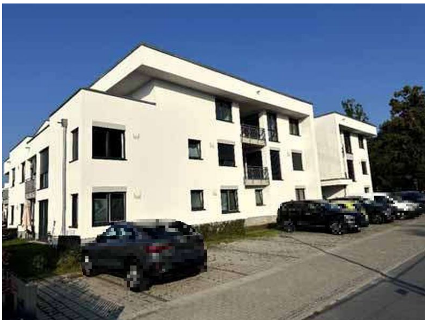
Bild 6: Seiten/Vorderansicht Gebäude Alte Werftstraße 1 (Haus H)
