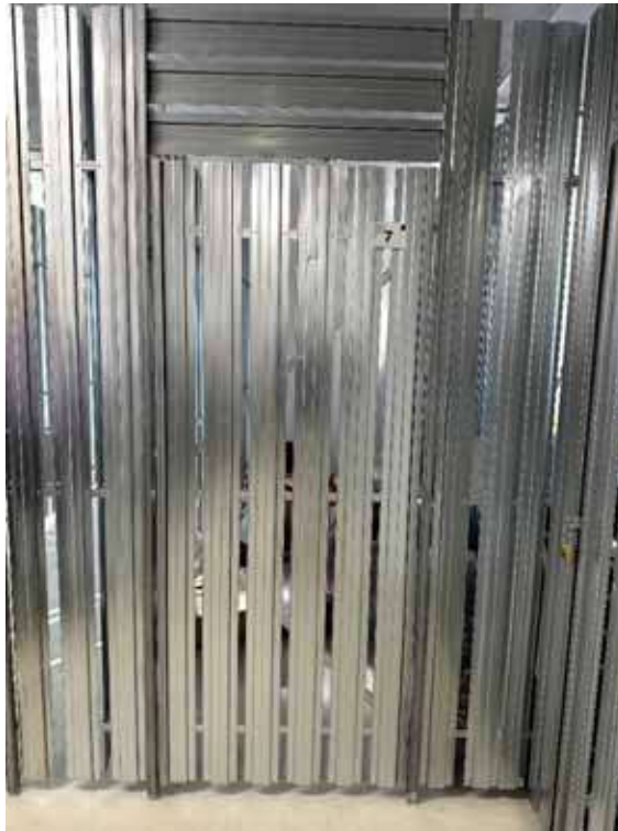
Bild 29: Abstellraum im EG, WE Nr. 29
