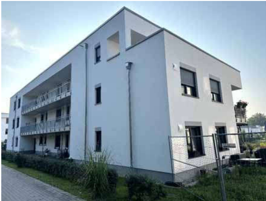
Bild 3: Straßenansicht Gebäude Karl-Marx-Straße 62 (Haus G)
