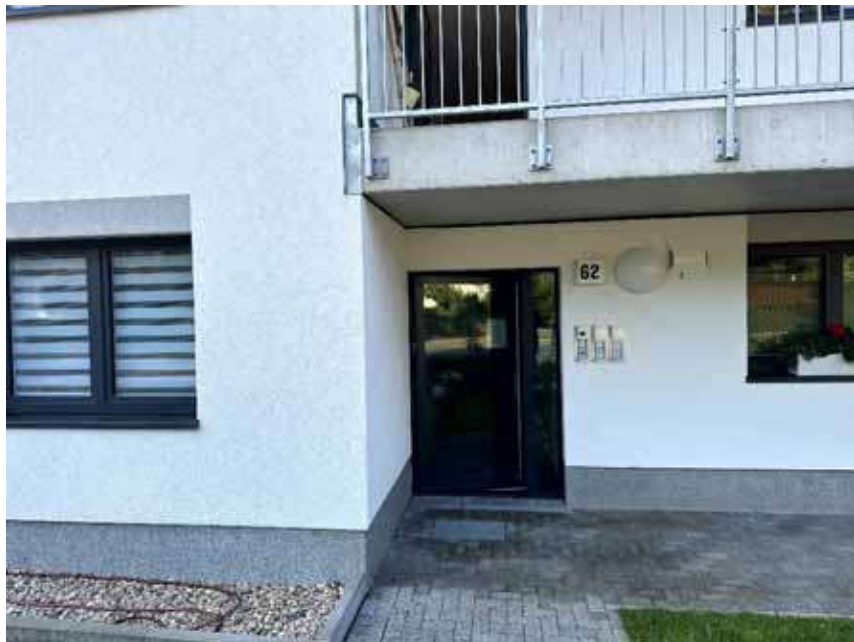
Bild 8: Hauseingang Gebäude Karl-Marx-Straße 62 (Haus G)
