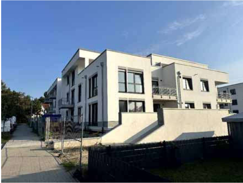
Bild 1: Straßen-/Seitenansicht Gebäude Lilienthal-Straße 2 (Haus F)
