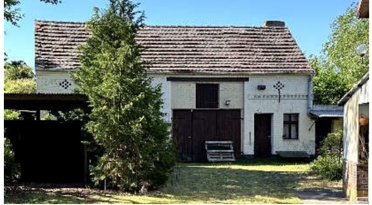
massiv, Satteldach, Holztür, Holztor, einfache Fenster
