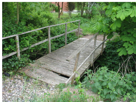
Brücke zum Flurstück 135/4
