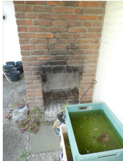
Bild 14: Teilansicht Wohnhaus Terrasse Außenkamin rückwärtig
