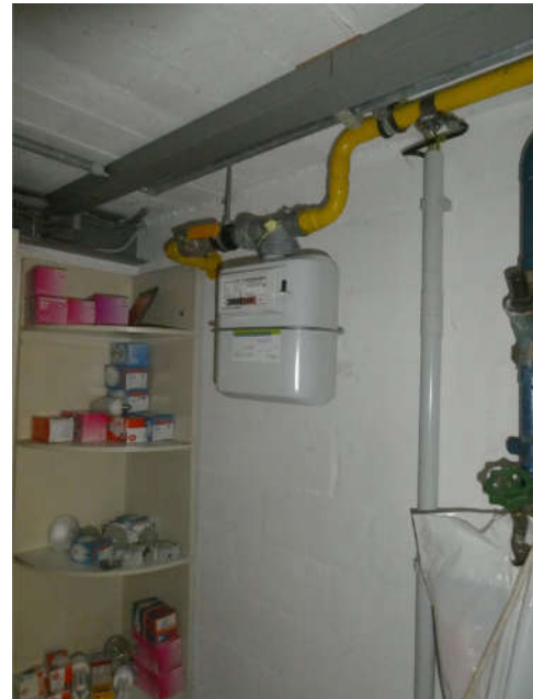
Bild 50: KG Gasanschluss
