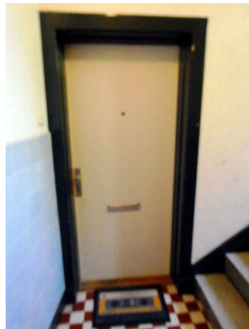
Bild 16: Nr. 24: Treppenhaus / typischer Bereich Wohnungseingang
