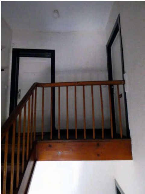
Bild 29: Nr. 22: Treppenhaus Bereich Dach
