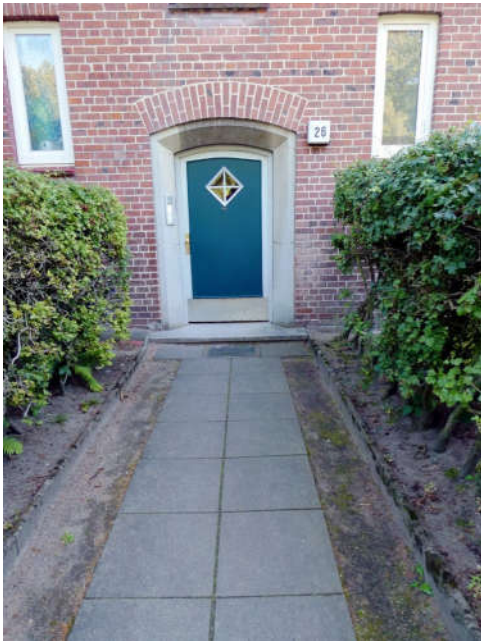
Bild 13: Bereich Hauseingang Nr. 26
