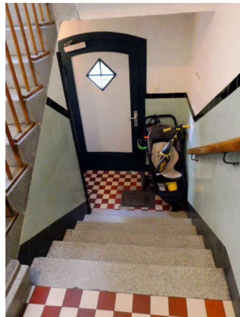
Bild 24: Nr. 22: Treppenhaus EG
