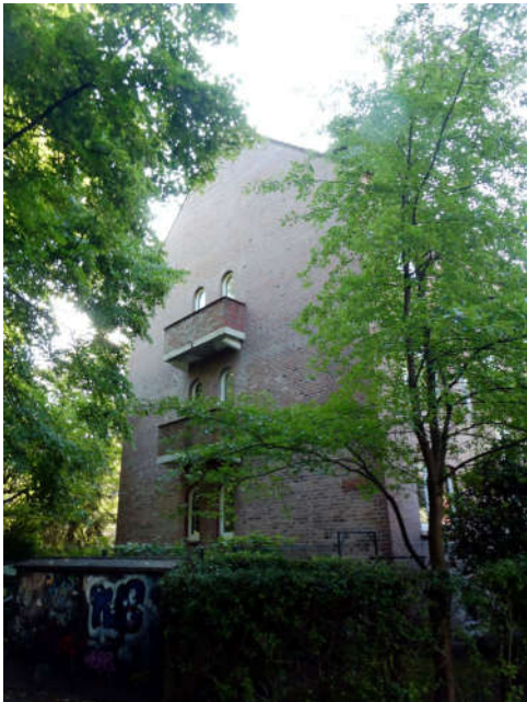
Bild 5: giebelseitige Ansicht von der Straße
