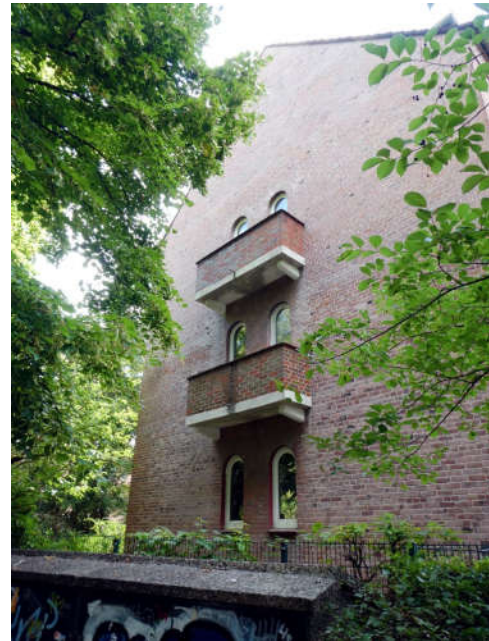
Bild 6: giebelseitige Ansicht von der Straße
