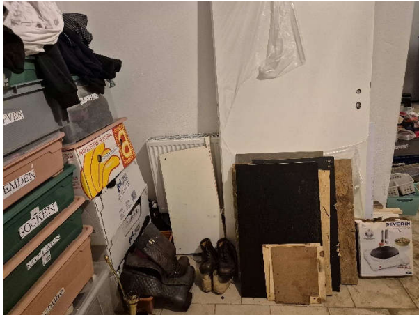
mit Unrat vollgestellter Kellerflur
