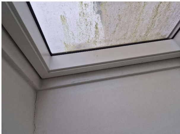
Dachflächenfenster im Abstellraum von Wohnung 5
