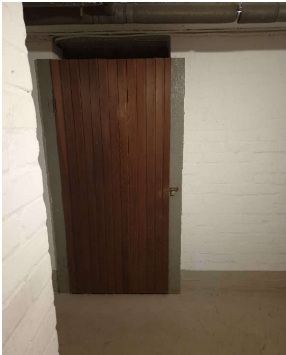
Kellertür von Keller Nr. 98
