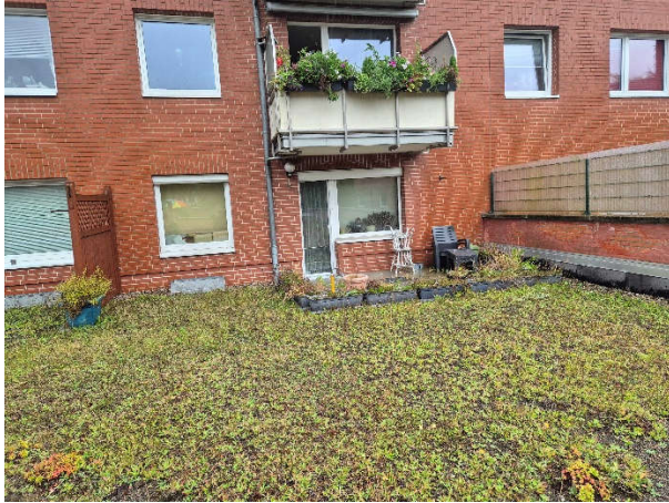
Terrasse und Kinderzimmerfenster
