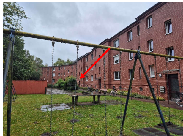
Mehrfamilienhauszeile mit den Eingängen Nr. 64-16, 64-14, 64-9a, 64-9, 64-11 (Nordostansicht)
