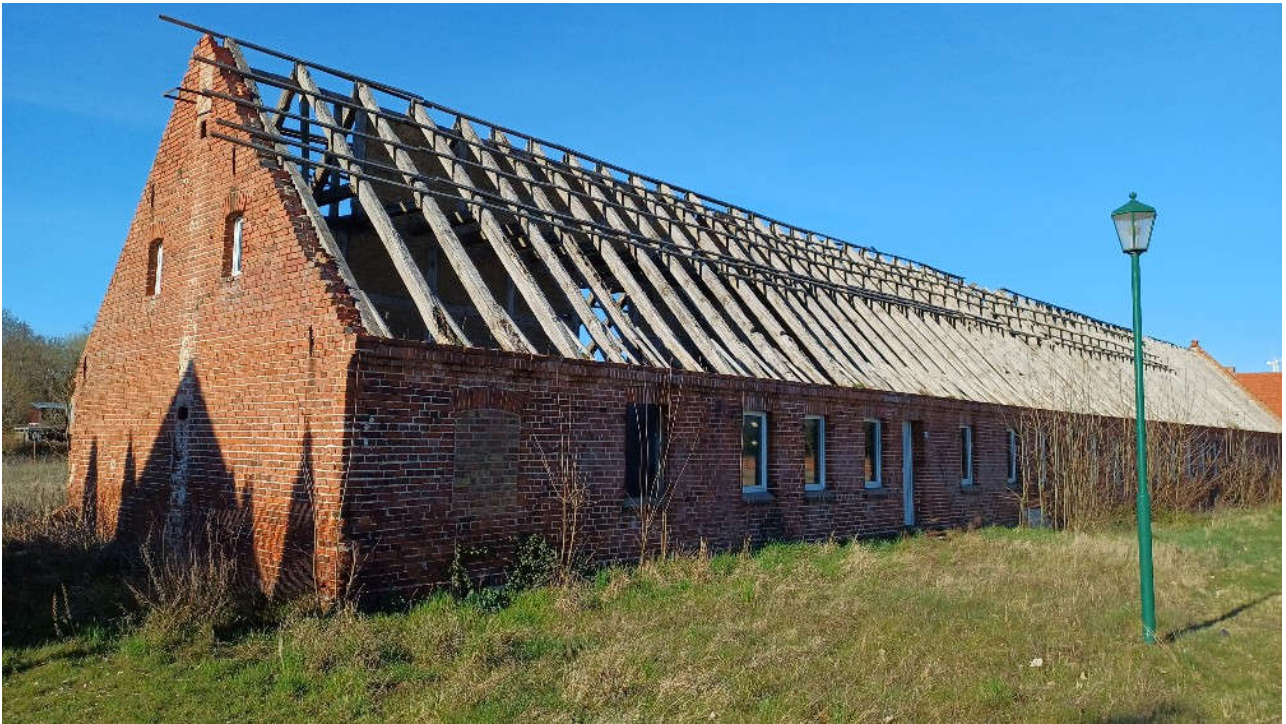
Abbildung 1: Ansicht von der Straße
