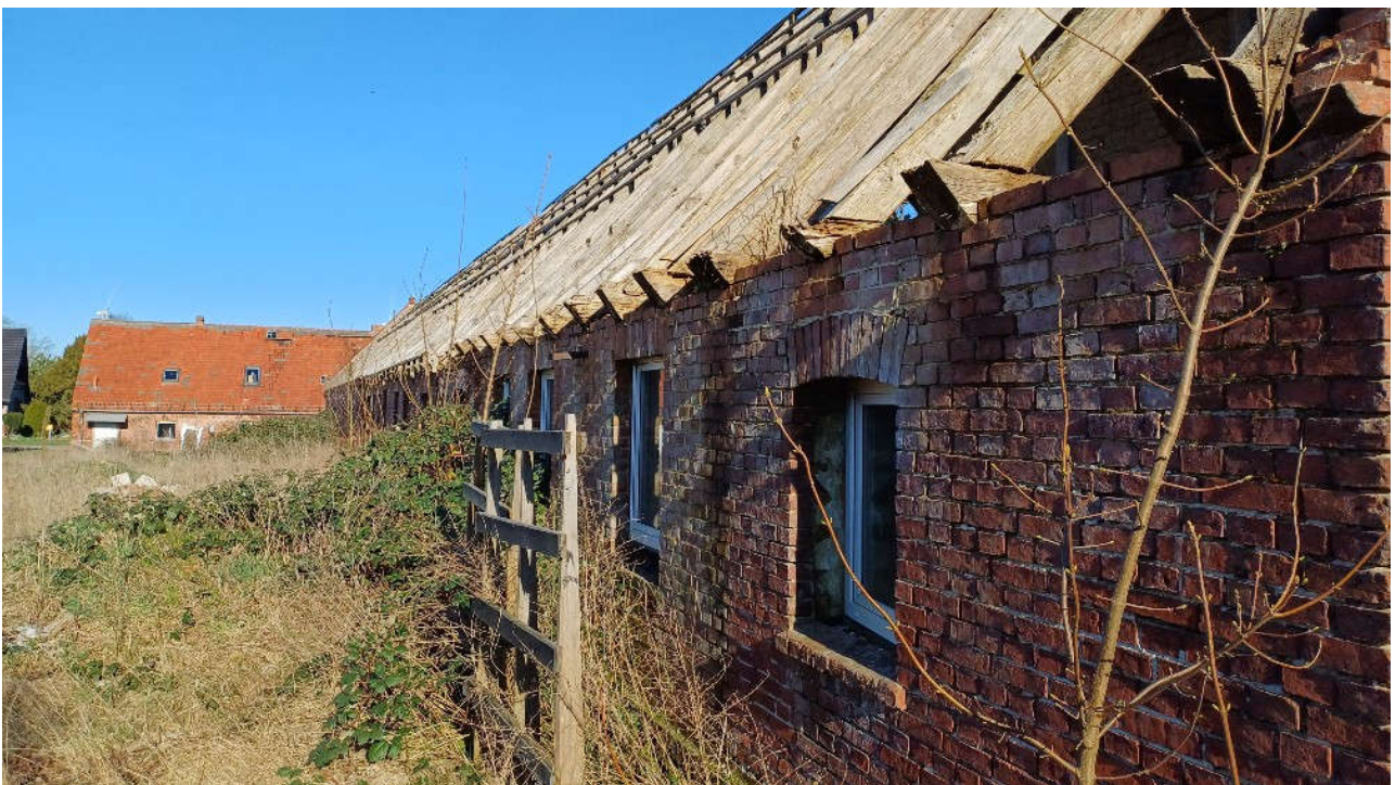
Abbildung 2: Ansicht von der Hofseite
