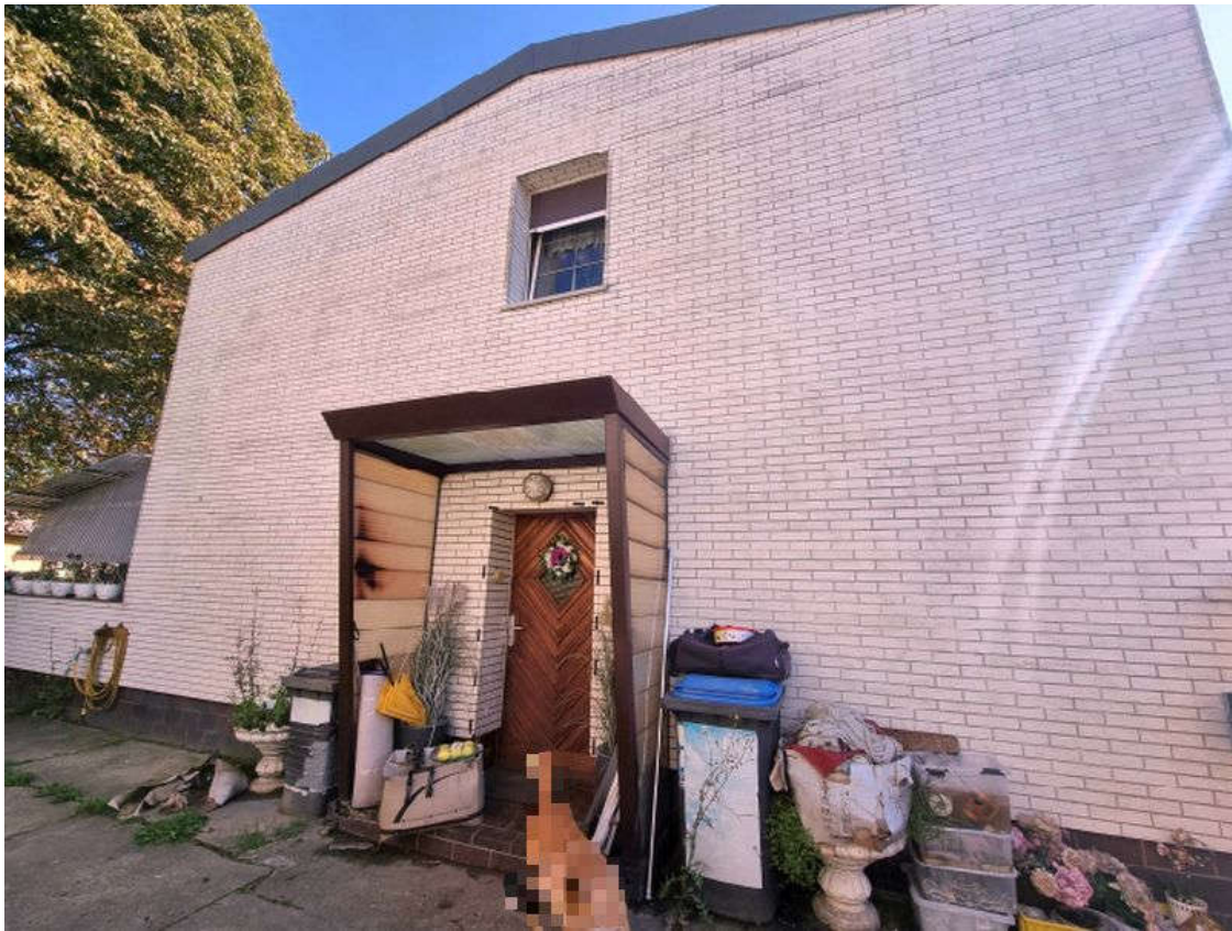
Giebel Wohnhaus, Hauseingang
