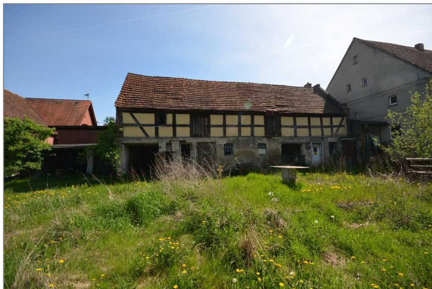
Nebengebäude Stall rechts
