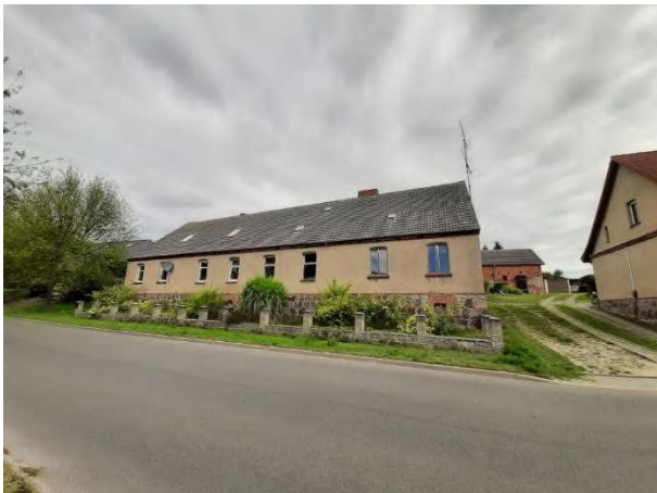
Bild 9: Ansicht von der Straße
