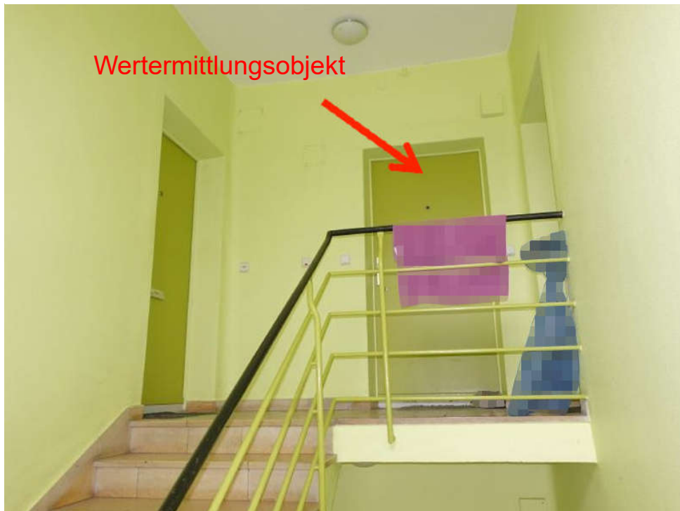
Wohnungseingangstür zur Wohnung WE 27 im 1. OG, Mitte
