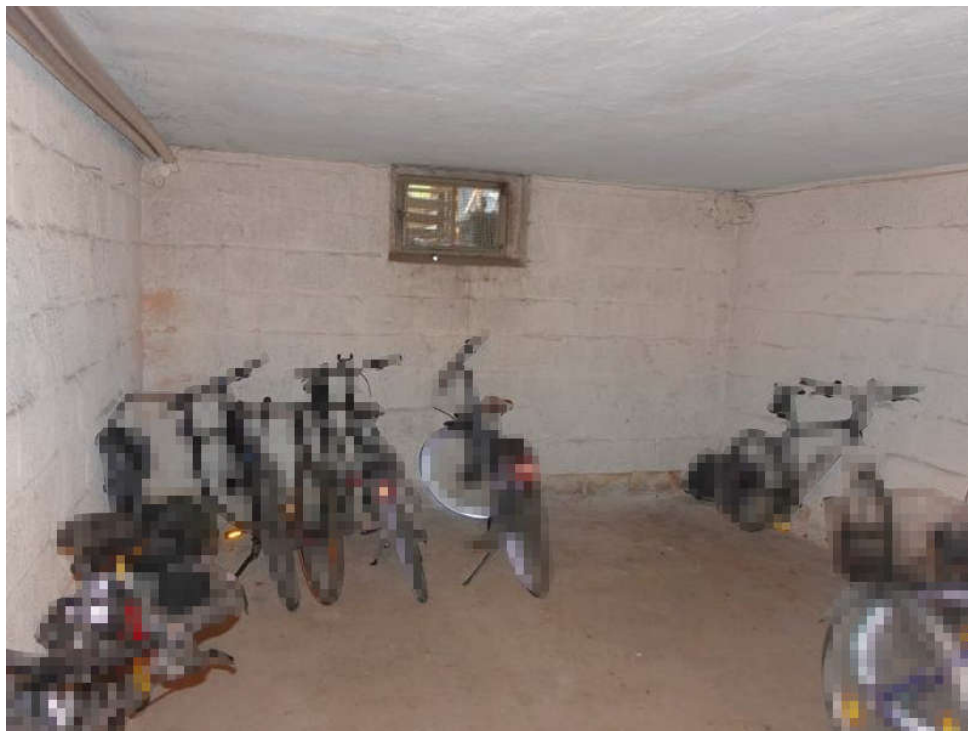
Kellergeschoss, gemeinschaftlicher Fahrradabstellraum
