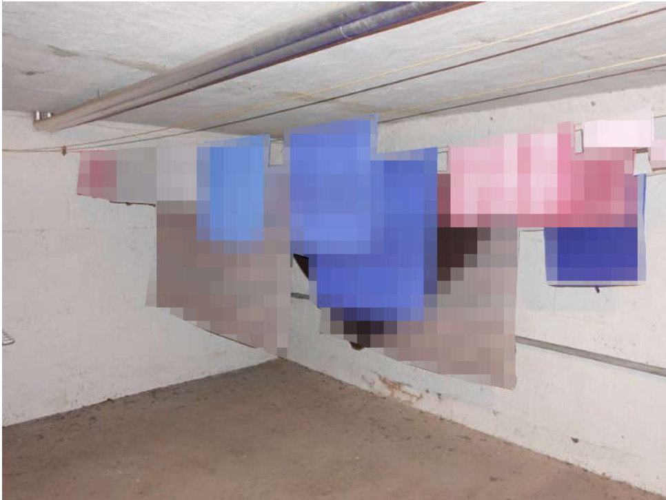
Kellergeschoss, gemeinschaftlicher Trockenraum
