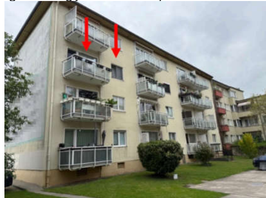
Rückansicht des Gebäudes (Bewertungswohnung jeweils markiert)
