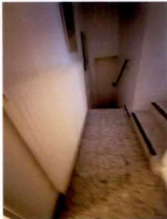
Zugangsflur vom Hauptgebäude
