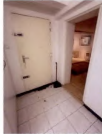
Flur – Zugangstüren Kellergarage, Hobbyraum
