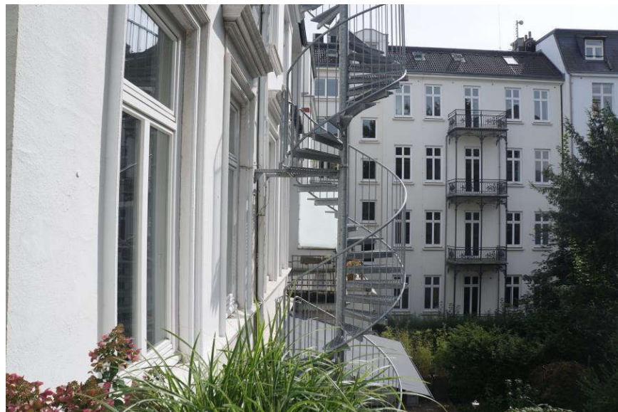
Rückfassade vom Nachbarhaus aus mit gemeinsamer Nottreppe
