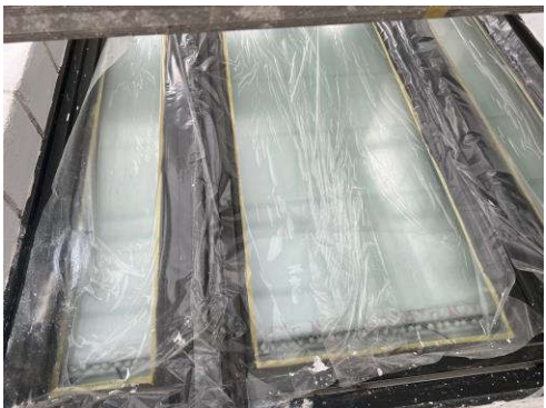
Detail Fenster Hochparterre
