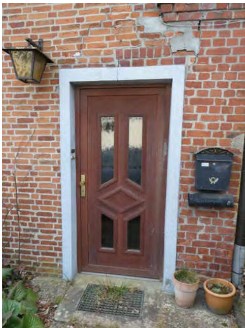
Bild 23: Whg Nr. 58b: Eingangsbereich
