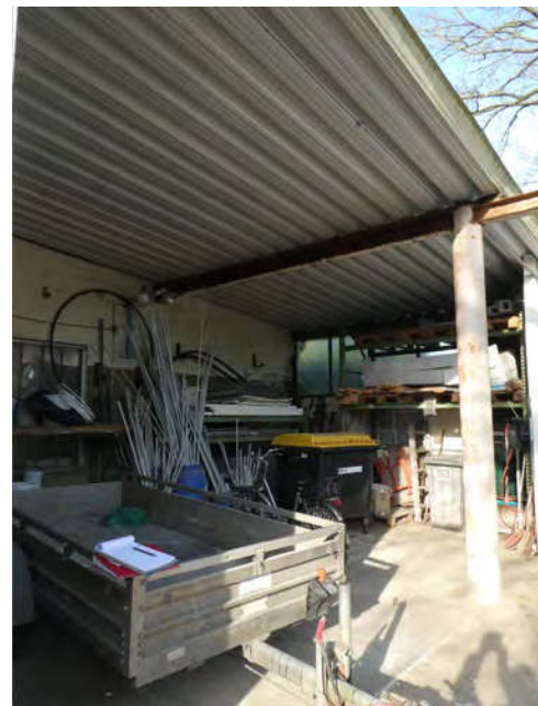
Bild 36: Werkstattgebäude , hofseitige Ansicht rückwärtig
