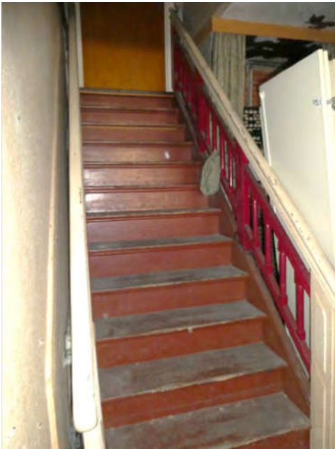
Bild 65: Abstellbereich Treppe in den Dachbereich
