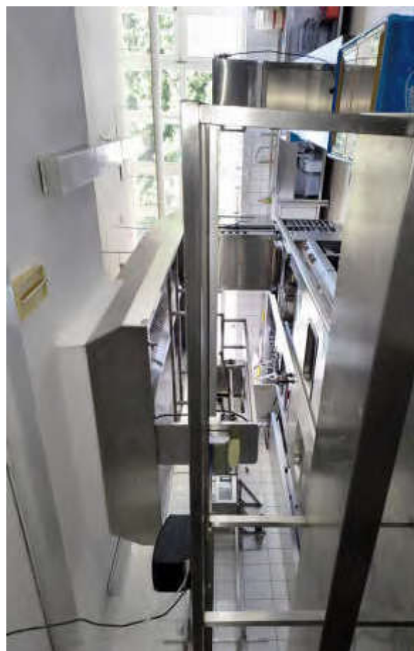
Bild 5-9 o Oben und Unten: Kellergeschoss vom Schloss Spyker: Ansichten der Gastroküche
