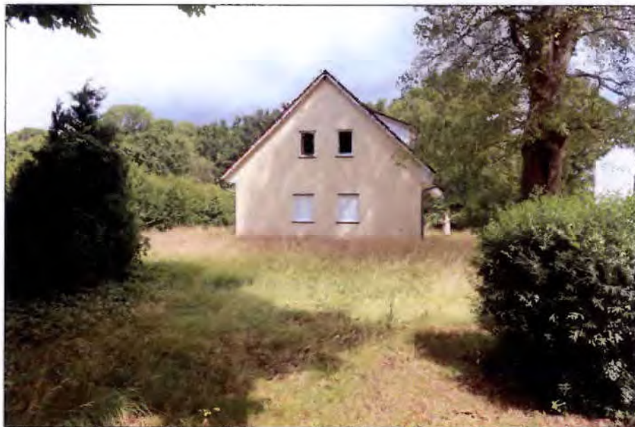
Blick auf das Gebäude aus südlicher Richtung
