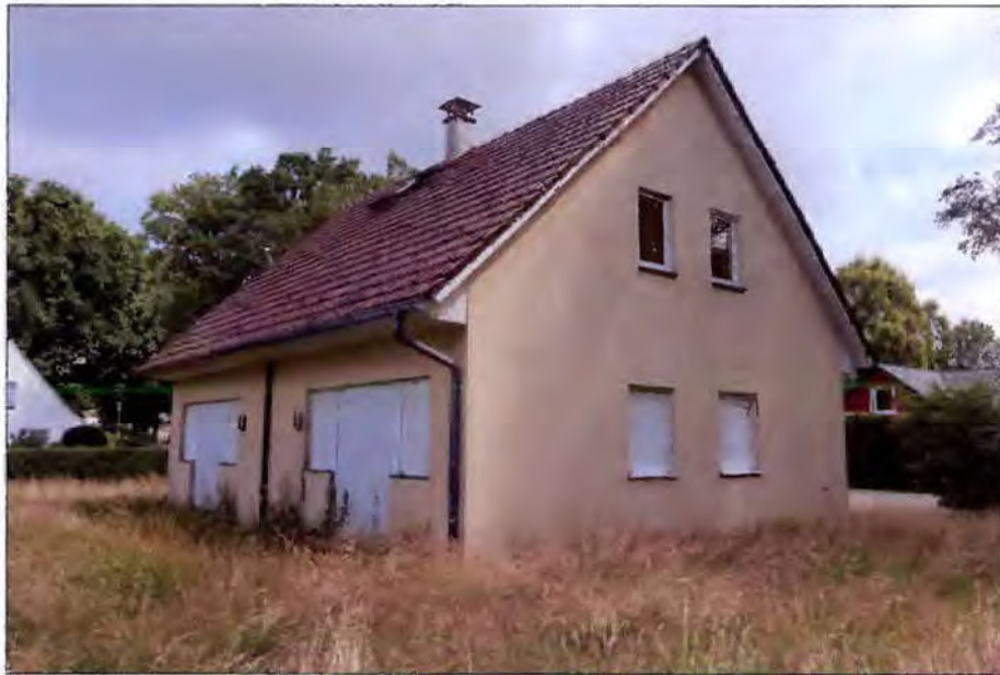
Blick auf das Gebäude aus südwestlicher Richtung
