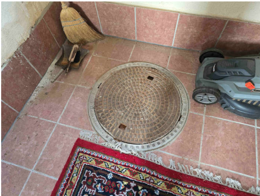
↑ Bild 40: Schmutzwasseranschluss im nördlichen Anbau (Haupteingang)
