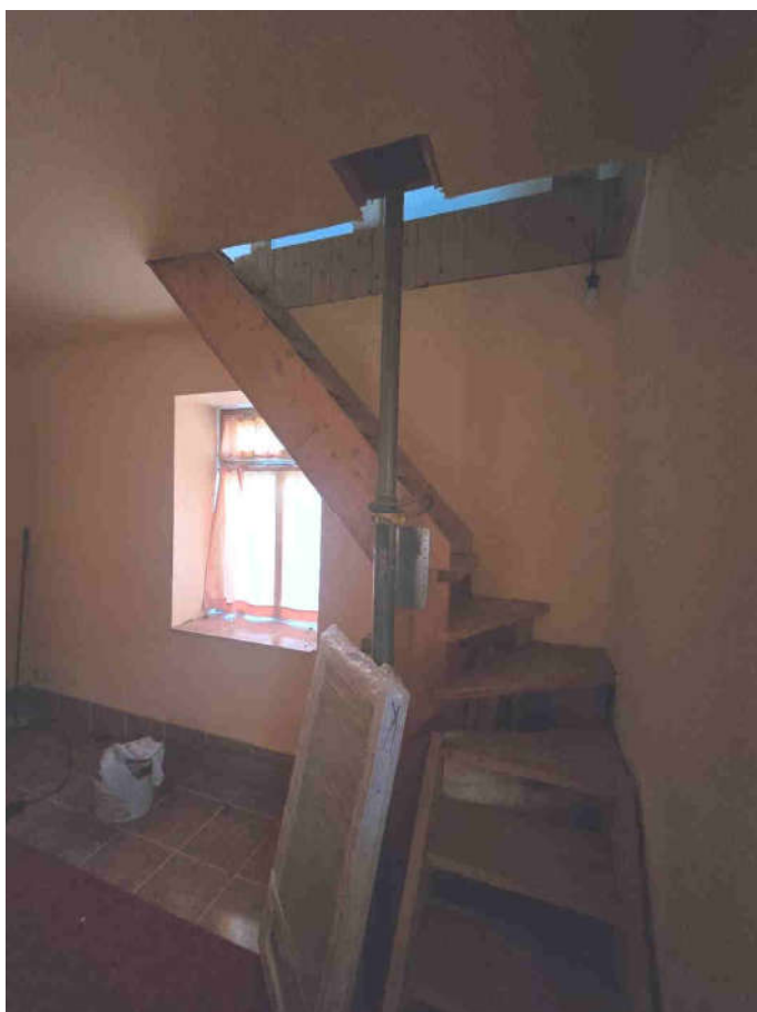
↑ Bild 26: Treppe zum Dachgeschoss im Kesselhaus
