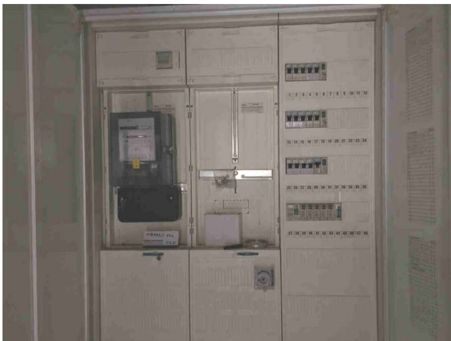
↑ Bild 20: Elektroverteiler
