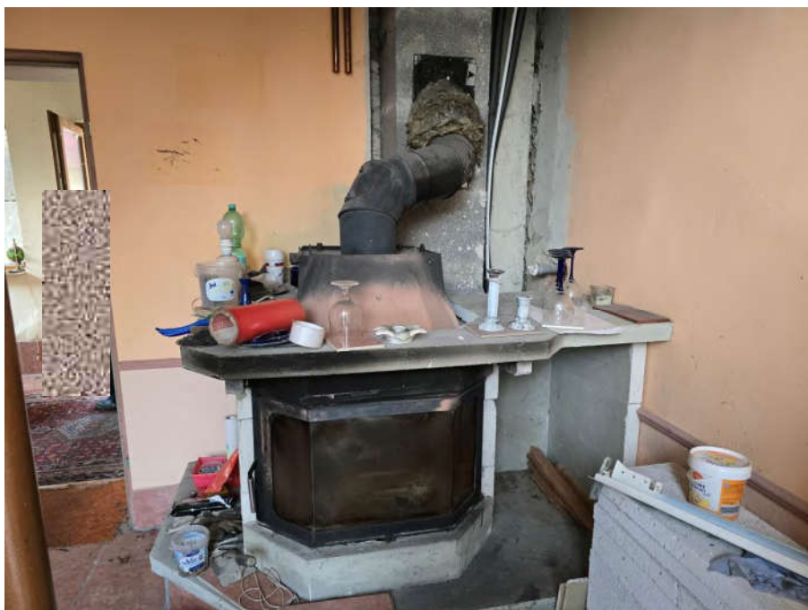
↑ Bild 13: unfertiger Kamin im Glashaus
