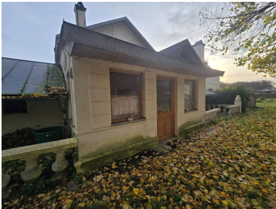
↑ Bild 11: Anbau mit Haupteingang
