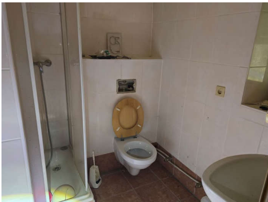
↑ Bild 14: Dusche/WC im Ostflügel
