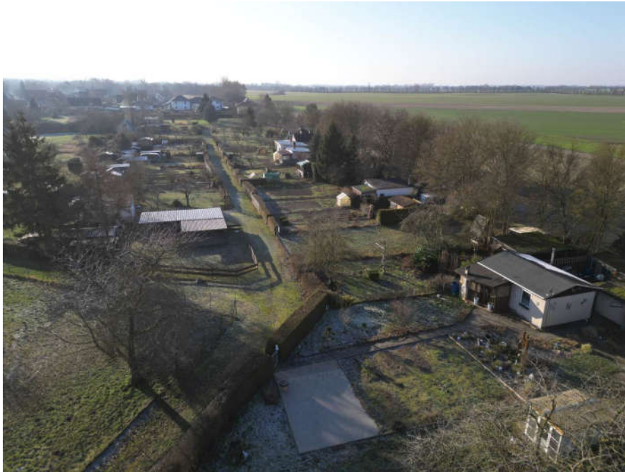
↑ Bild 1: Blick aus Richtung Nordosten über das Bewertungsgrundstück (Drohnenaufnahme)
