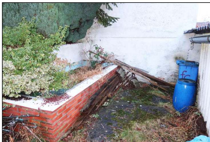
ehemaliges Wasserbecken nördlich des Nebengebäudes
