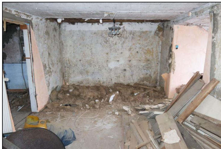
Blick in das Dachgeschoss (straßenseitiges Zimmer)
