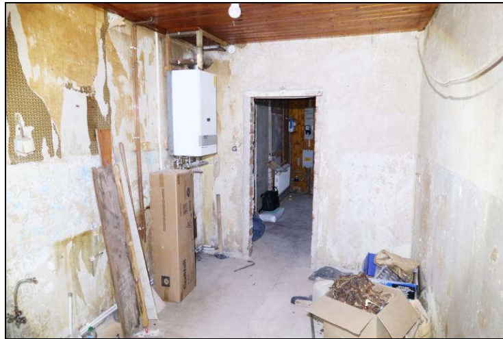
Durchgangszimmer 1 im Erdgeschoss (ohne Fenster)
