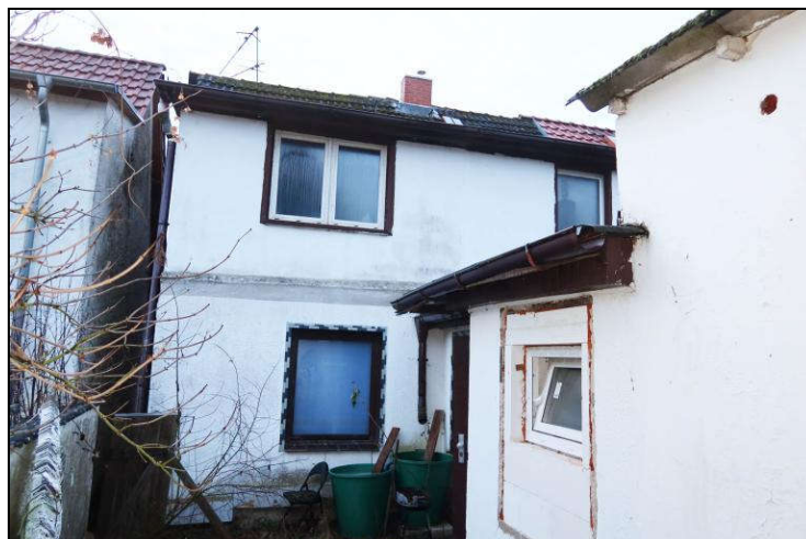
Blick auf das Reihenhaus aus nördlicher Richtung (Anbau im Vordergrund)
