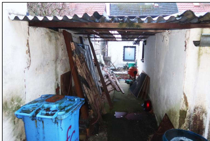
Blick auf den überdachten Unterstand am Nebengebäude
