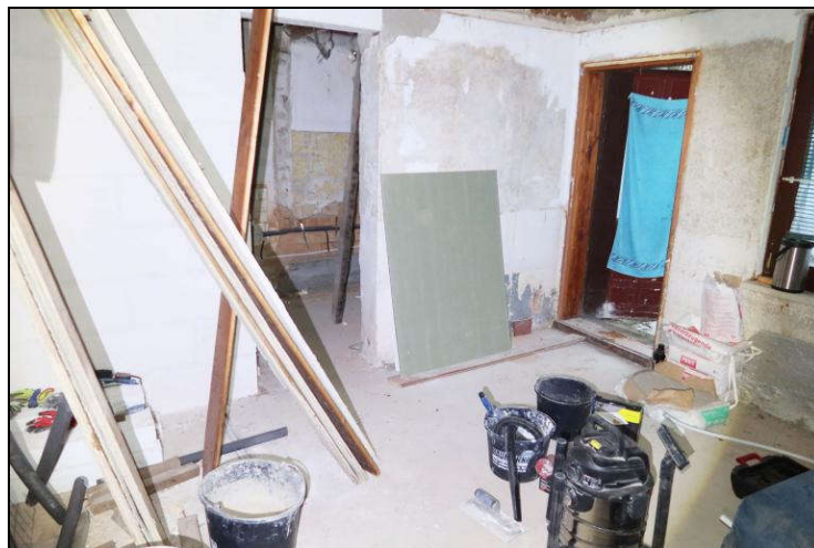
Durchgangszimmer 2 im Erdgeschoss (Anbau)
