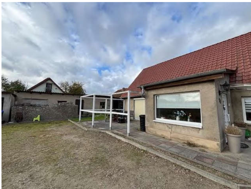
Bild 4: Ansicht Einfamilienhaus und Nebengebäude von der Straßenseite aus
