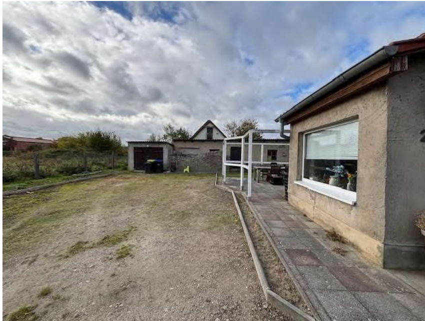
Bild 5: Ansicht Einfamilienhaus und Nebengebäude von der Straßenseite aus
