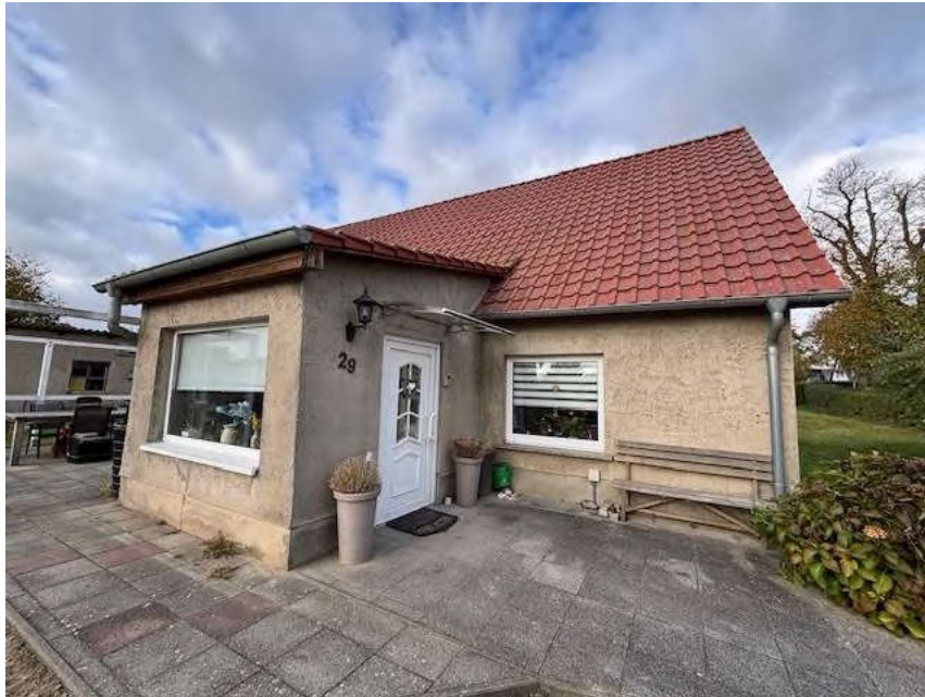
Bild 3: Ansicht Einfamilienhaus von der Straßenseite aus
