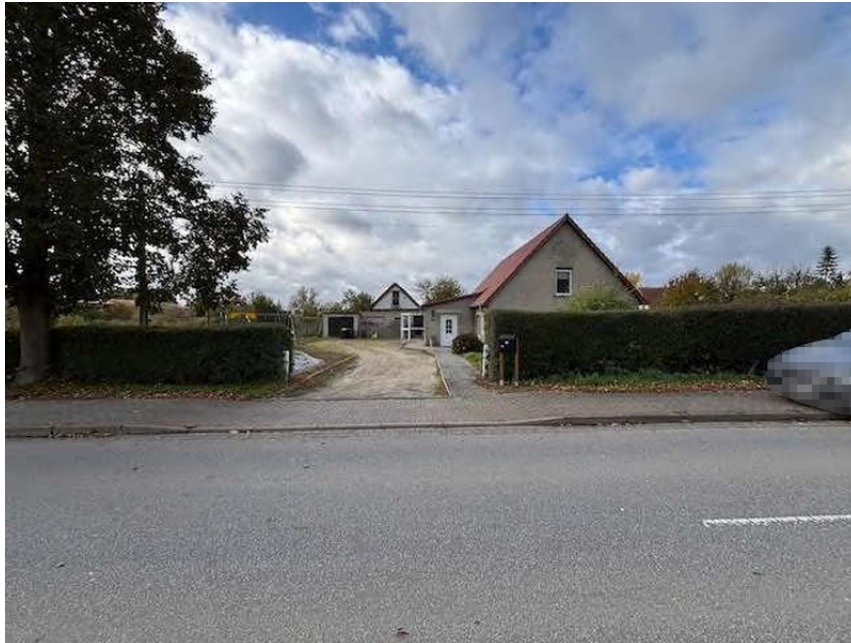
Bild 1: Ansicht von der Straße (Ostseite) aus
