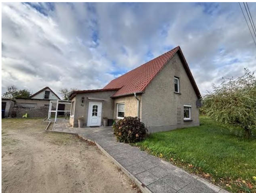
Bild 2: Ansicht Einfamilienhaus von der Straßenseite aus
