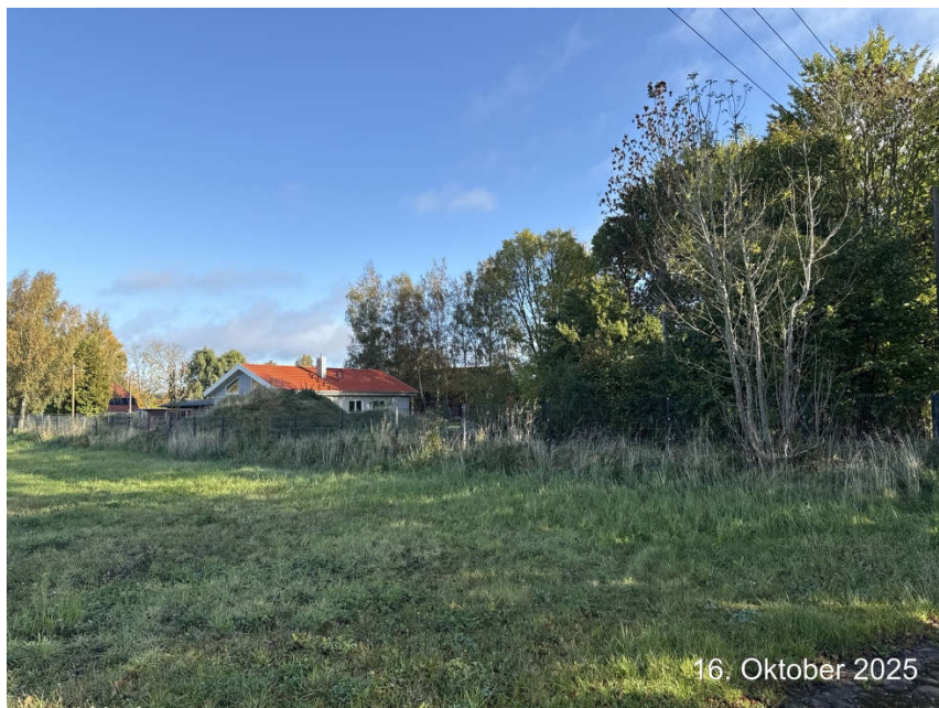
Bild 4: Darstellung des Bewertungsobjekts aus südwestlicher Richtung
