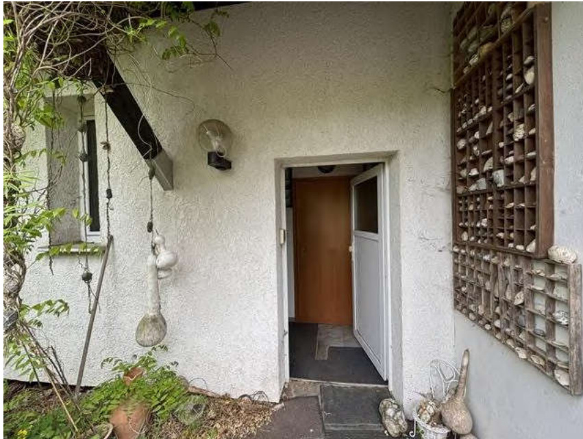
Bild 25: Außenansicht Wohn- und Abstellgebäude
