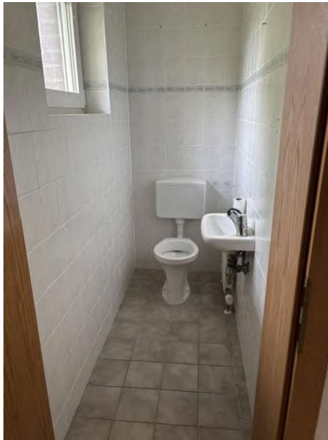
Bild 10: Einfamilienhaus, Gäste-WC EG
