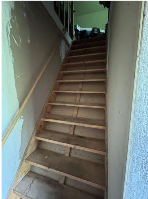
Bild 21: Innenansicht Garagengebäude, Treppe an der Gebäuderückseite zum Dachraum
