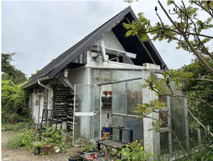
Bild 23: Außenansicht Wohn- und Abstellgebäude
