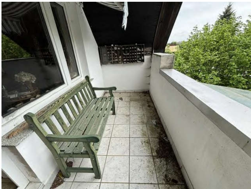
Bild 36: Wohn- und Abstellgebäude, DG Balkon
