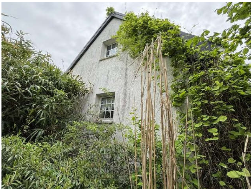
Bild 26: Außenansicht Wohn- und Abstellgebäude
