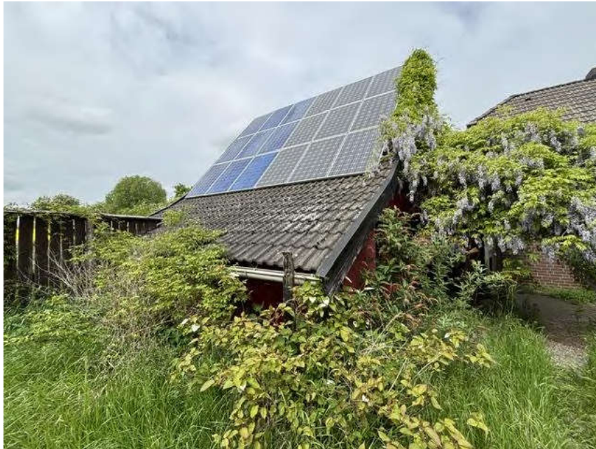
Bild 7: Garagengebäude, Außenansicht Hofseite
