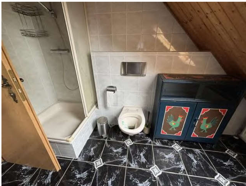
Bild 18: Einfamilienhaus, Bad DG
