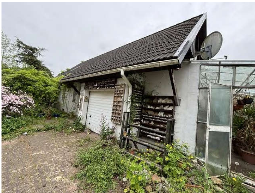
Bild 24: Außenansicht Wohn- und Abstellgebäude
