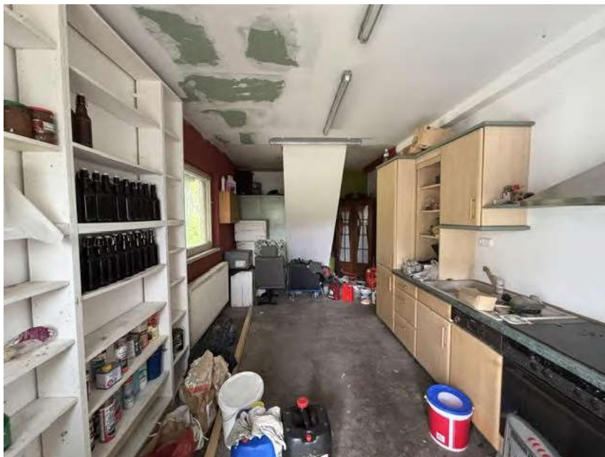
Bild 20: Innenansicht Garagengebäude (Hauswirtschaftsraum)
