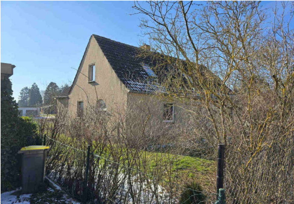
↑ Bild 5: Blick auf den Ostgiebel des Einfamilienwohnhauses
