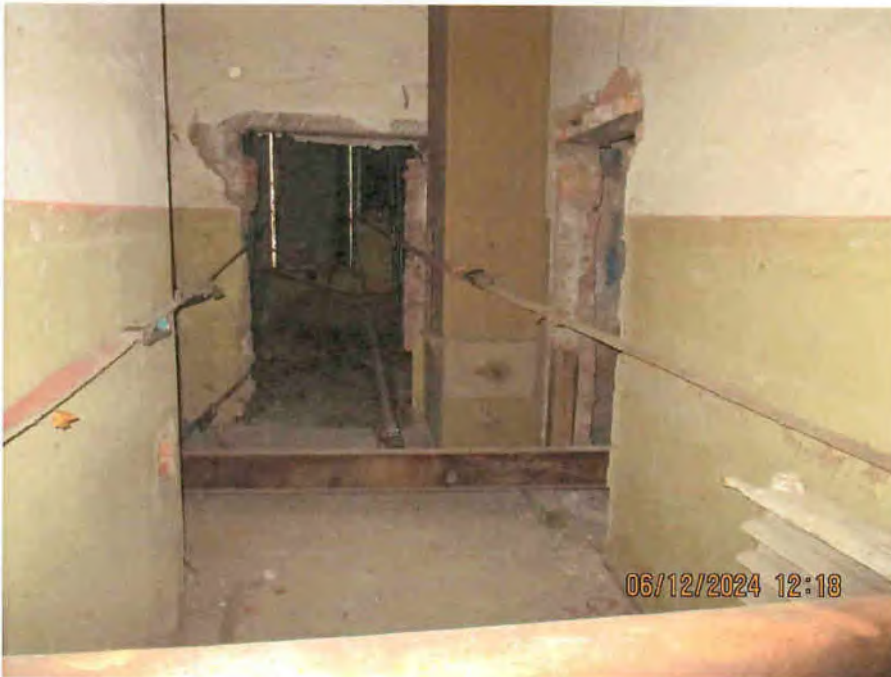
Sicherung Westgiebel: Mit Gurten verzurrt
