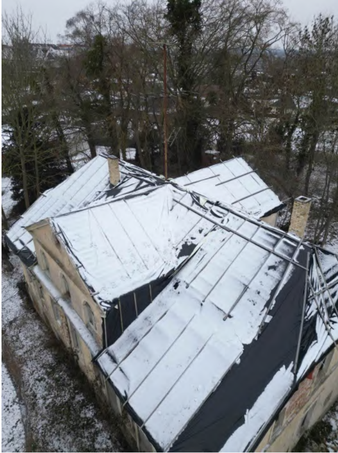
← Bild 15: südlicher Dachbereich
