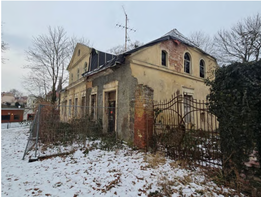
↑ Bild 7: Blick auf den Ostgiebel der ehemaligen Villa
