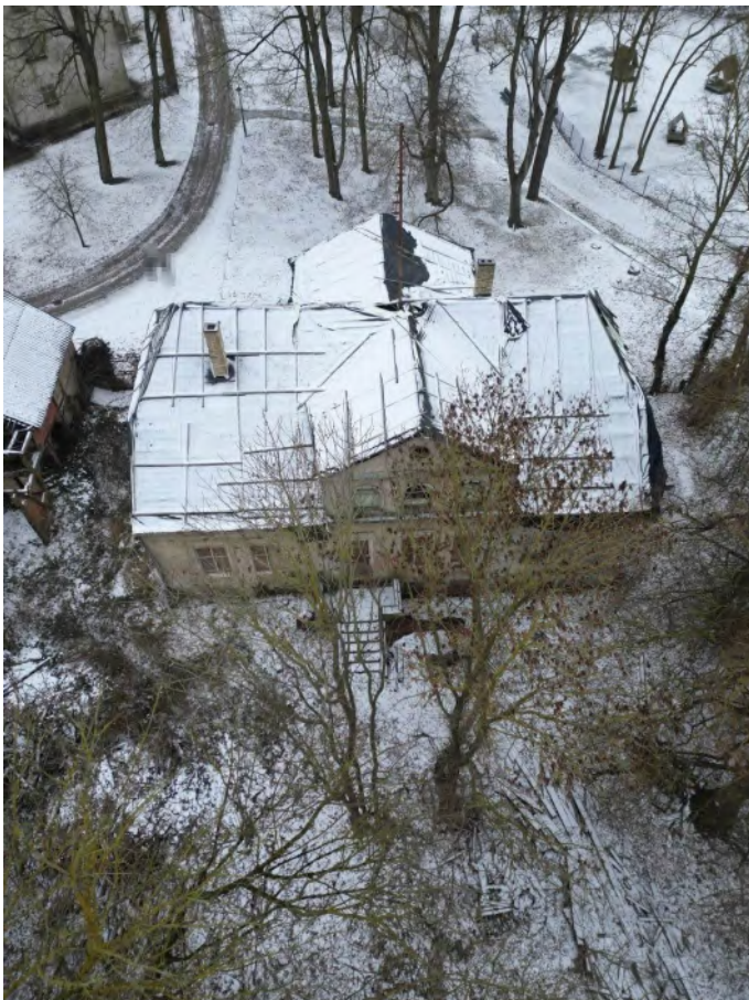
← Bild 16: nördlicher Dachbereich
