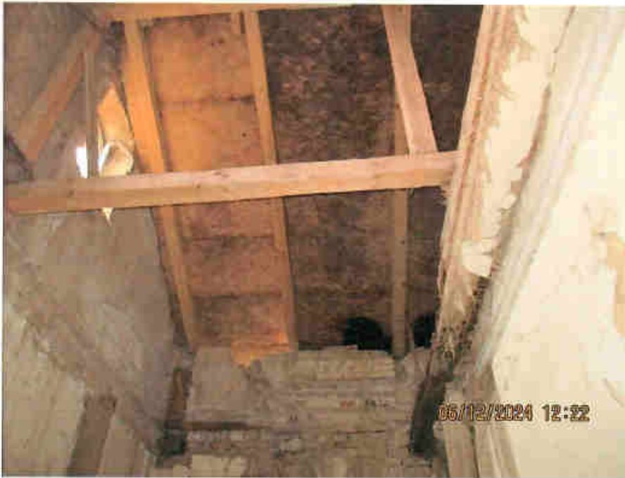
Geschlossene Dachfläche, Innenansicht
