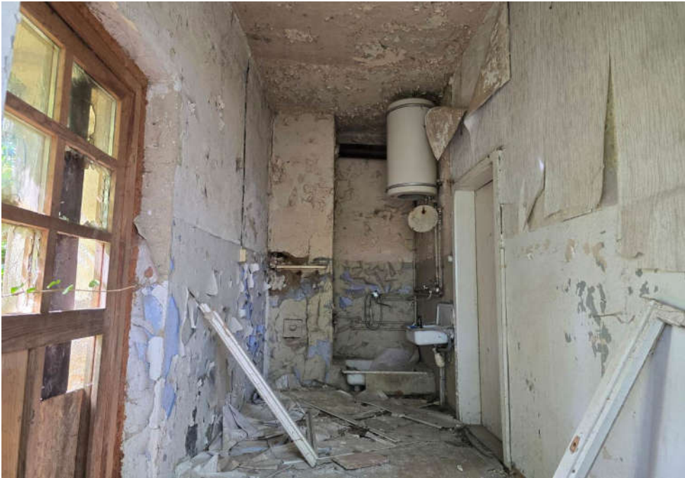
↑ Bild 7: Blick durch ein Fenster von der Treppe am Südgiebel aus
