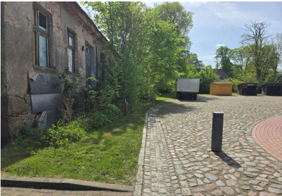
↑ Bild 12: Blick entlang der Westseite, einschließlich gepflasterter Verkehrsfläche
