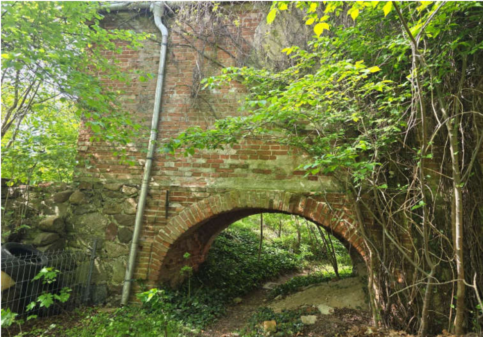
↑ Bild 5: angebaute Mauer am Südgiebel
