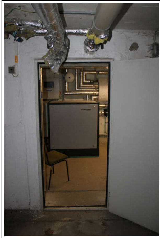
Foto 7 Zugang zur Heizzentrale im Aufgang Nr. 20
