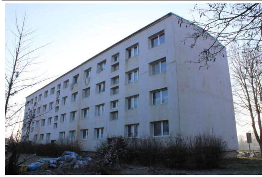
Foto 1 Grundstücks- und Gebäudeansicht aus Nordosten
