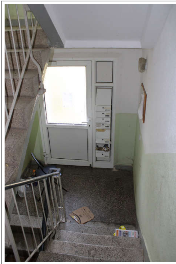
Foto 29 Beispielansicht Treppenhause im Erdgeschoss; hier mit Hauseingangstür und Briefkastenanlage
