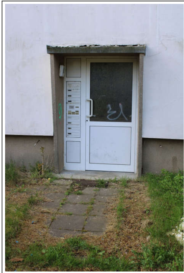
Foto 3 Beispielansicht Hauseingang mit Briefkastenanlage
