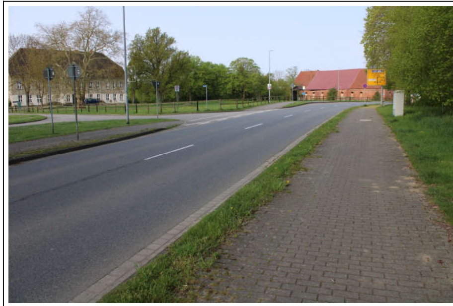
Foto 33 Ansicht der Bundesstraße mit Gehwegen vor dem Bewertungsobjekt
