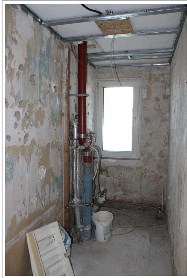
Foto 21 Beispielansicht einer Wohnung mit begonnener Sanierung/Modernisierung; hier das Bad
