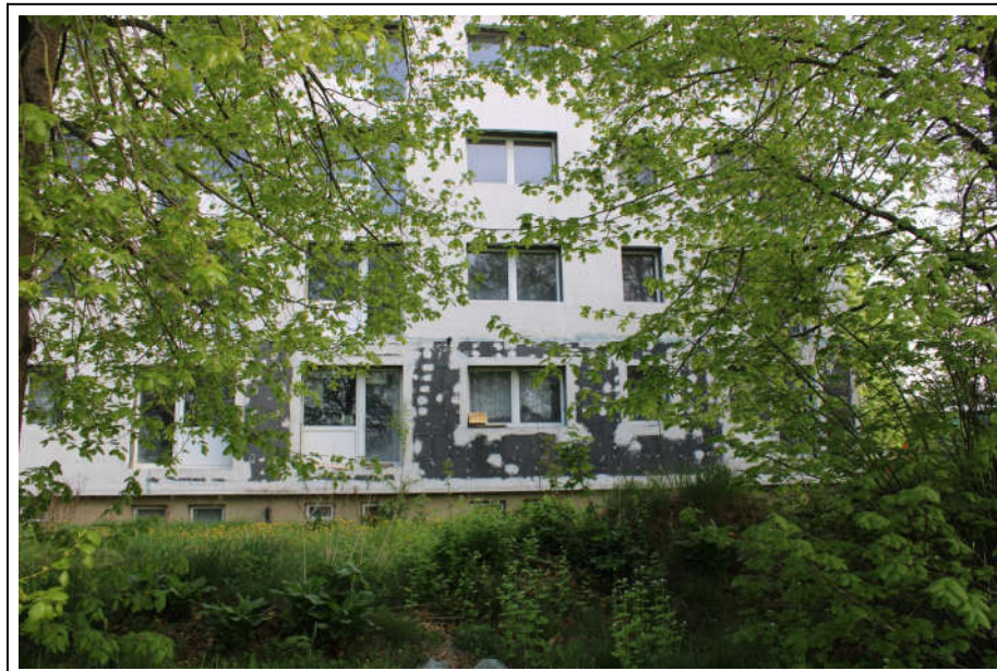
Foto 32 Ansicht des noch nicht verspachtelten, gedämmten Wohnhausbereiches im Erdgeschoss der Nr. 20
