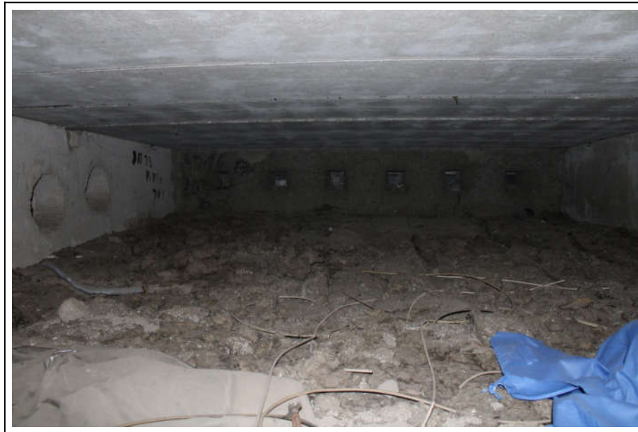
Foto 27 Beispielansicht Dachraum; Dach aus Stahlbeton, oberhalb der Geschossdecke Dämmung aus Kamilit
