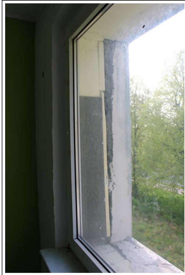
Foto 25 Beispielansicht Außenwand mit neu aufgebrachtter Wärmedämmung
