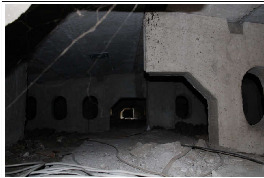
Foto 28 Beispielansicht Dachraum mit Längsblickrichtung
