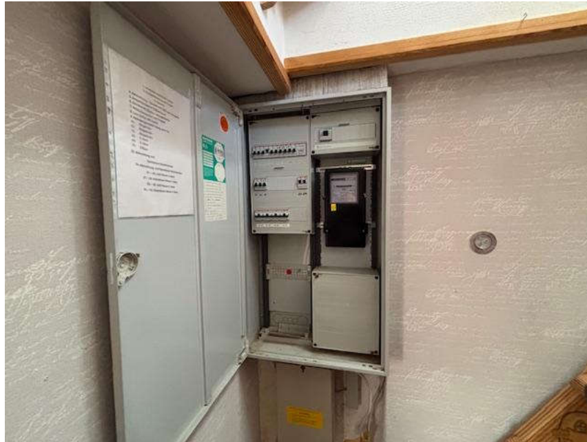
Bild 13: Flurstück 429, Innenansicht Doppelhaushälfte, Flur EG
