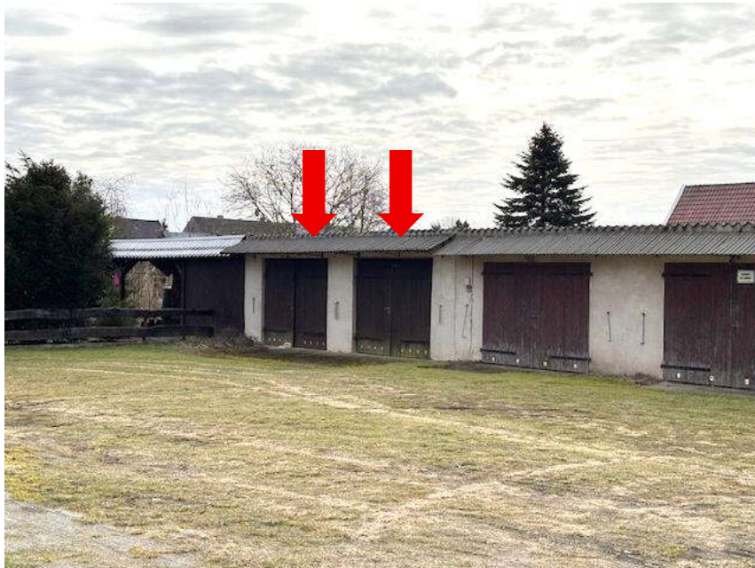
Bild 22: Flurstücke 463 und 464, 2 Garagen
