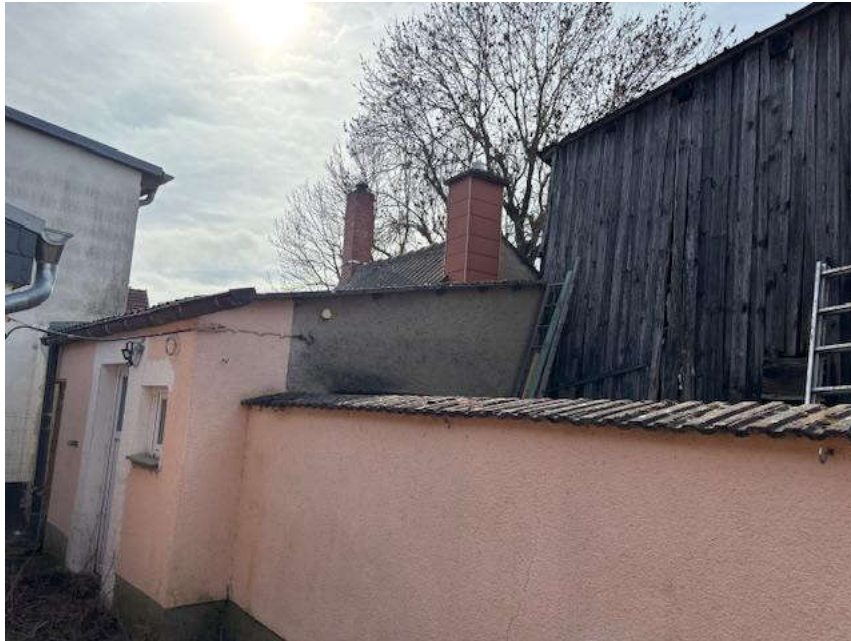
Bild 7: Flurstück 429, Ansicht Massivschuppen
