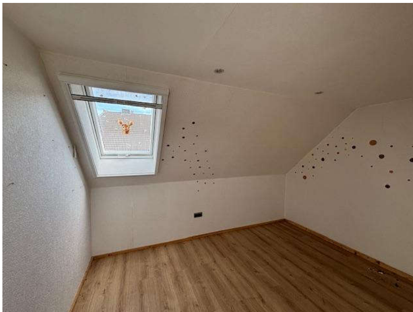
Bild 18: Flurstück 429, Innenansicht Doppelhaushälfte, Kinderzimmer DG
