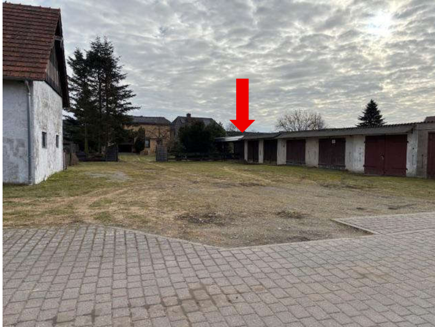
Bild 21: Flurstücke 463 und 464, Garagen
