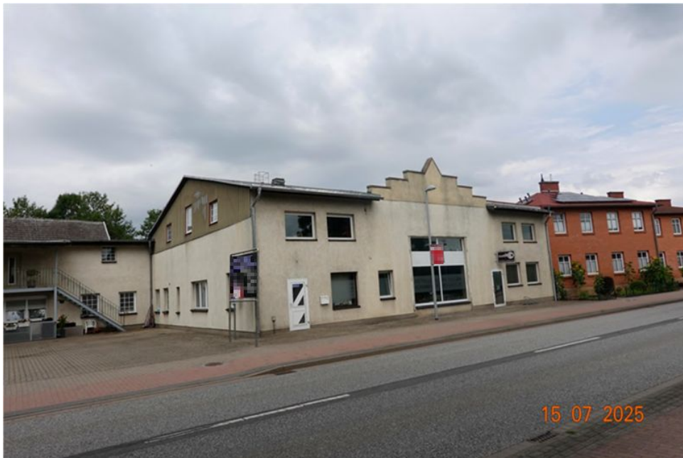
Bild 21: Darstellung des Werkstattgebäudes aus südwestlicher Richtung
