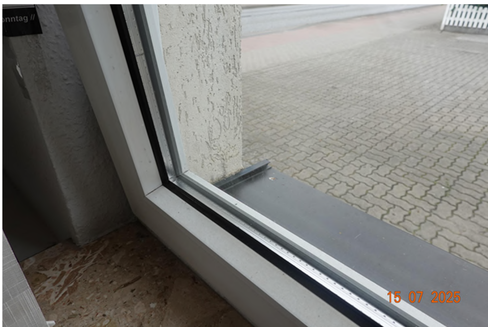
Bild 18: Darstellung der Wanddicke des Gebäudes
