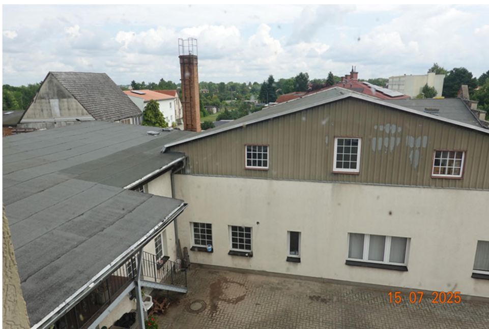
Bild 24: Darstellung der Dacheindeckung des Werkstattgebäudes und der Arbeiterunterkunft
