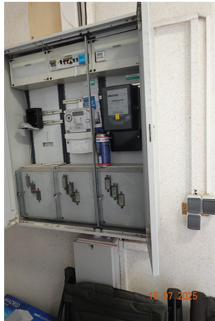
Bild 9: Darstellung des E-Hausanschlusses und der E-Zähler
