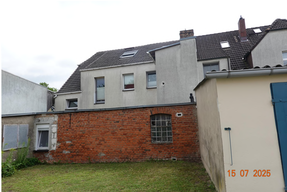
Bild 5: Darstellung des Zweifamilienhauses aus nordwestlicher Richtung
