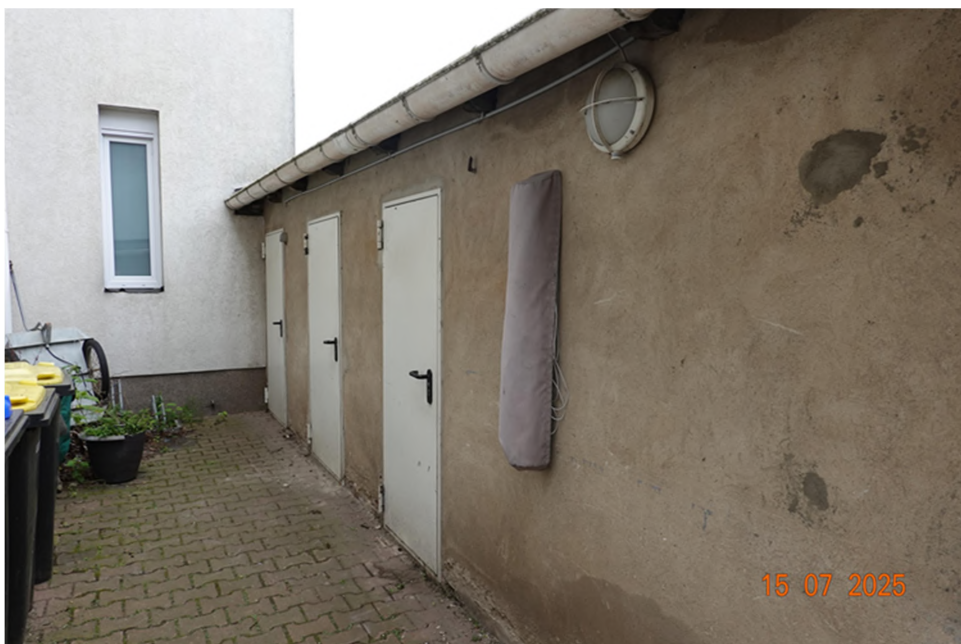
Bild 14: Darstellung der Vorderseite des Nebengebäudes
