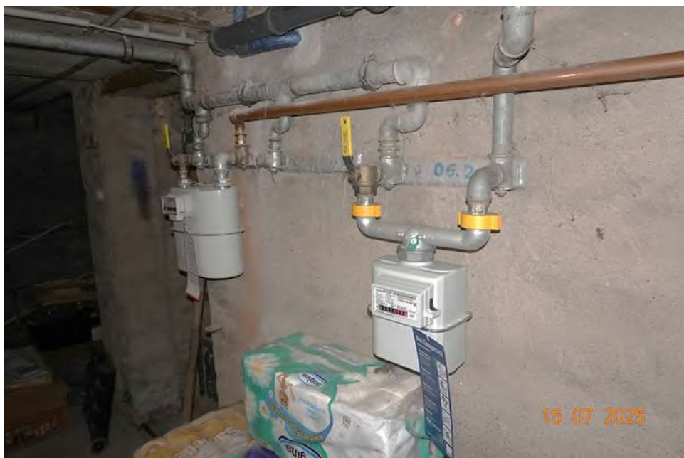
Bild 6: Darstellung der zwei Gaszähler im KG
