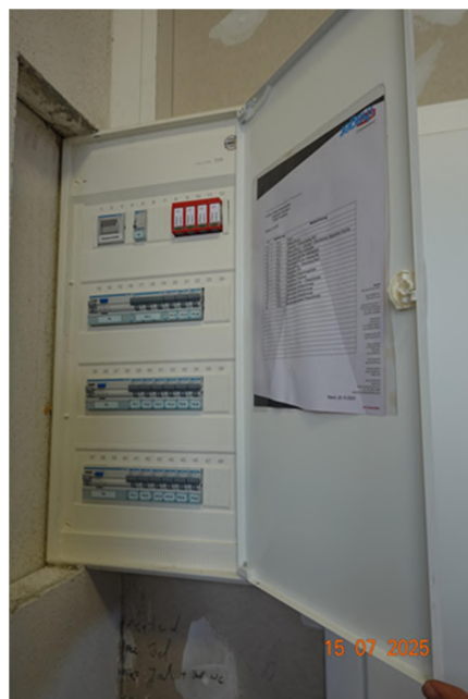
Bild 10: Darstellung der E-Verteilung im EG
