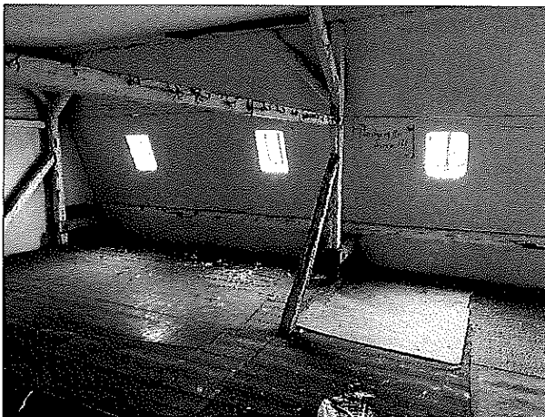
baulicher Zustand des Dachgeschosses
