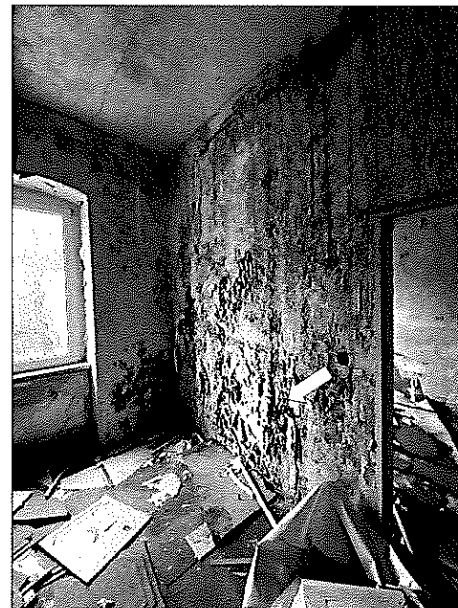
baulicher Zustand der Wohnräume der Wohnung Nr. 3 im 1. Obergeschoss, ⇒ massiver Schwarzsimmelbefall
