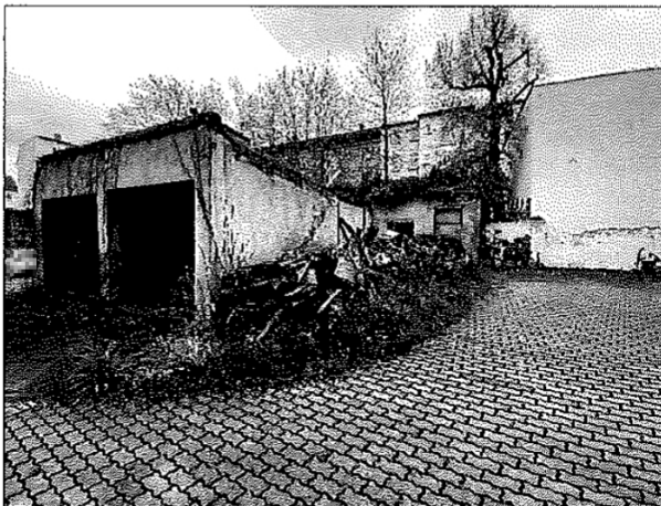
Nebengebäude im Bereich der südöst- lichen Grundstücksecke, Ansicht aus Richtung Nordwesten
