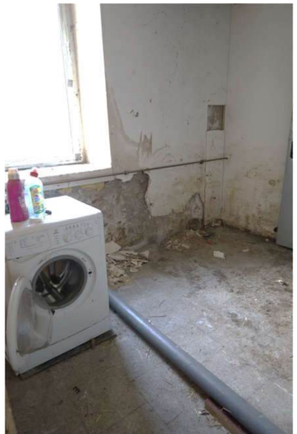
Durchfeuchtetes Mauerwerk
