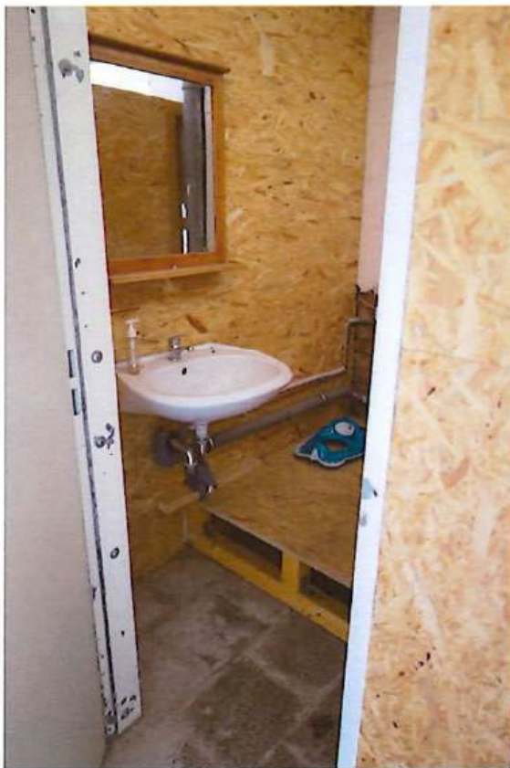
Einbauten im Durchgangszimmer
