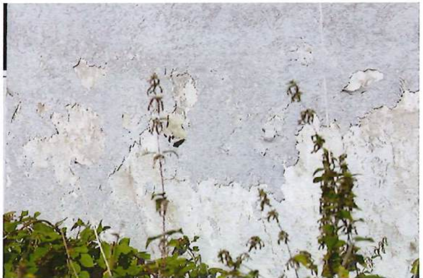
Sichtschäden (Feuchteinwirkung)
