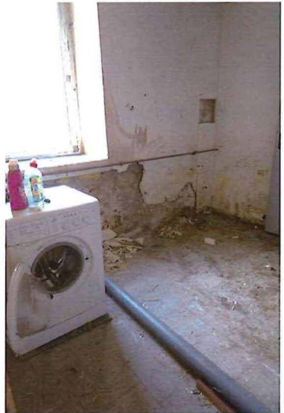
Durchfeuchtetes Mauerwerk
