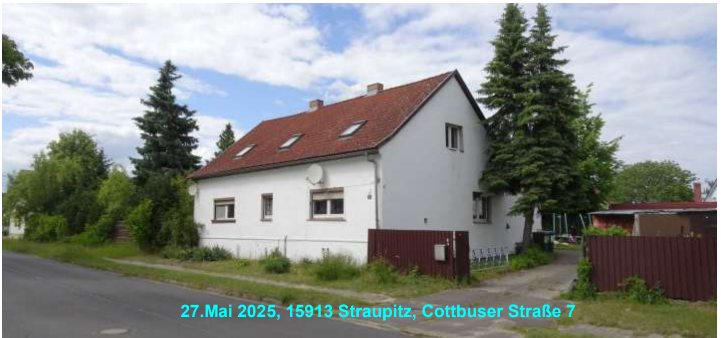
Ansicht der Wohnhauses von der Straßenseite
