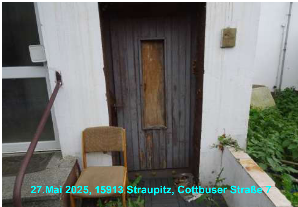
Wohnhaus – Detail zu dem Wohnhaus und dem Zugang zu dem Keller
