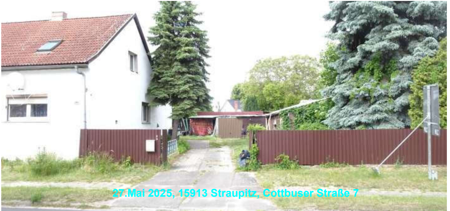
Detail zu der Hofeinfahrt
