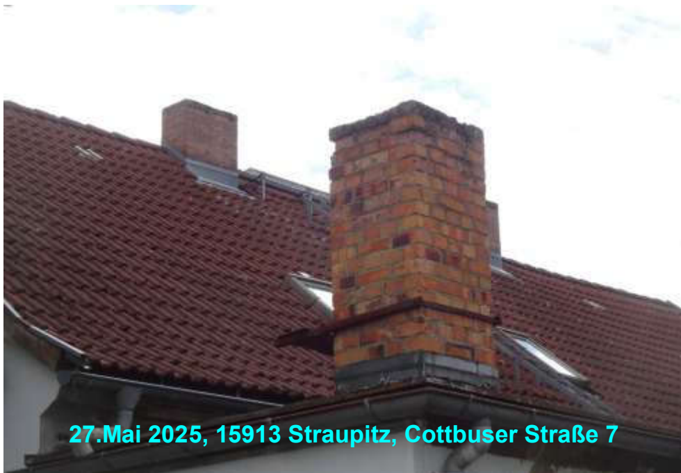
Wohnhaus – Detail zu dem Dach von der Hofseite (links)
