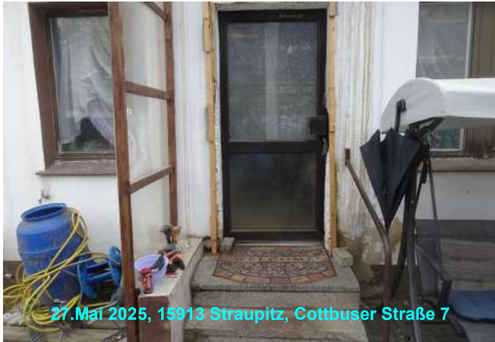
Wohnhaus – Detail des linken Hauseinganges
