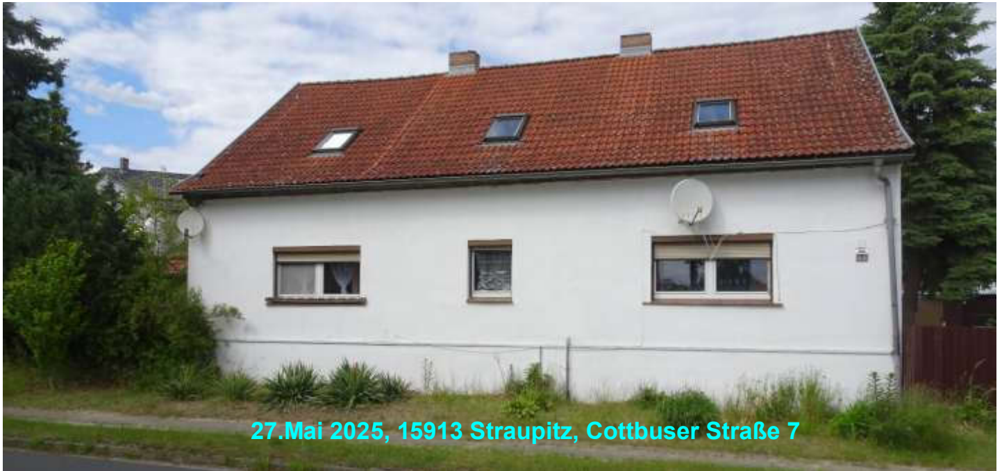
Ansicht der Wohnhauses von der Straßenseite
