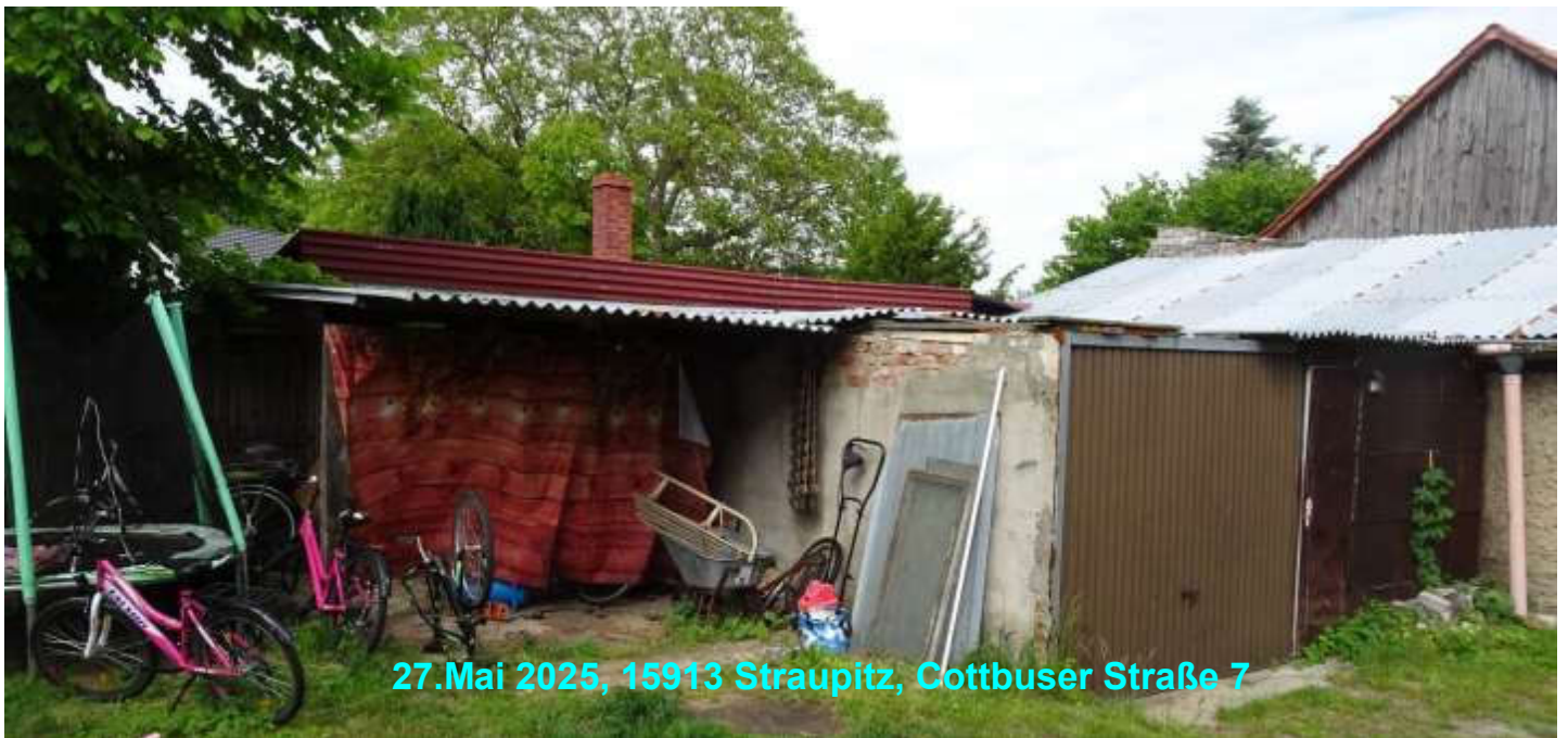
Ansicht der sonstigen Bebauung
