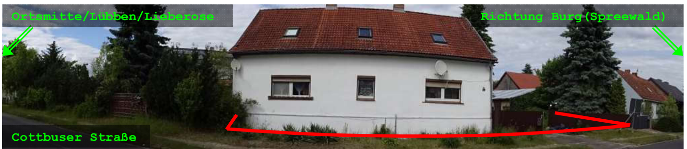
Gesamtsituation in der Cottbuser Straße mit Blick zu dem Grundstück
