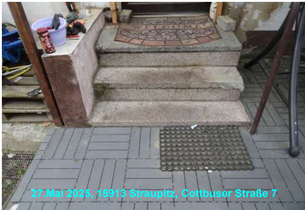
Wohnhaus – Detail des linken Hauseinganges mit der Eingangstreppe
