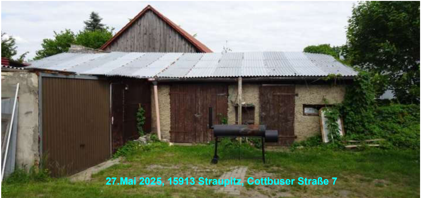
Ansicht der sonstigen Bebauung
