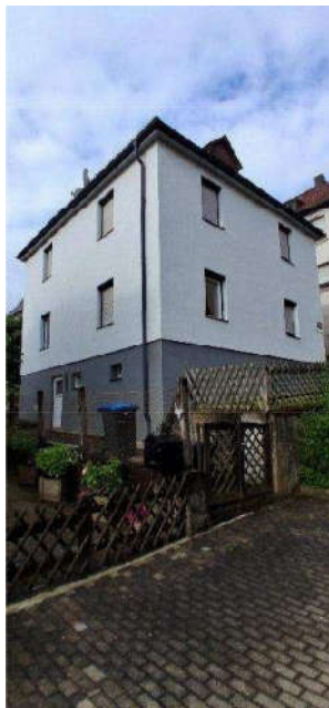
Ansicht Straßenseite aus Nordosten
