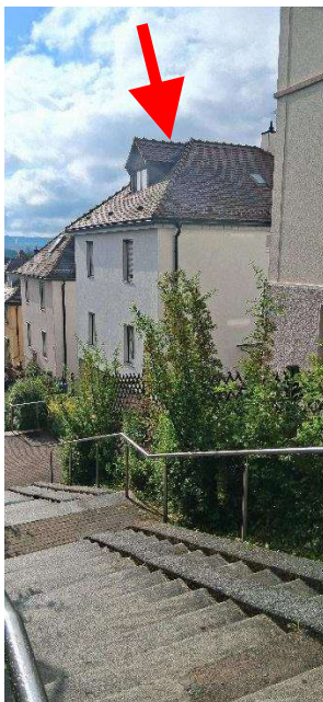
Bild 3: Blick von Treppenanlage nach Osten
