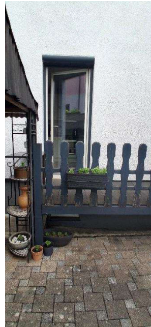
Bild 14: Rückseitiger Terrassenvorbau EG-Ebene
