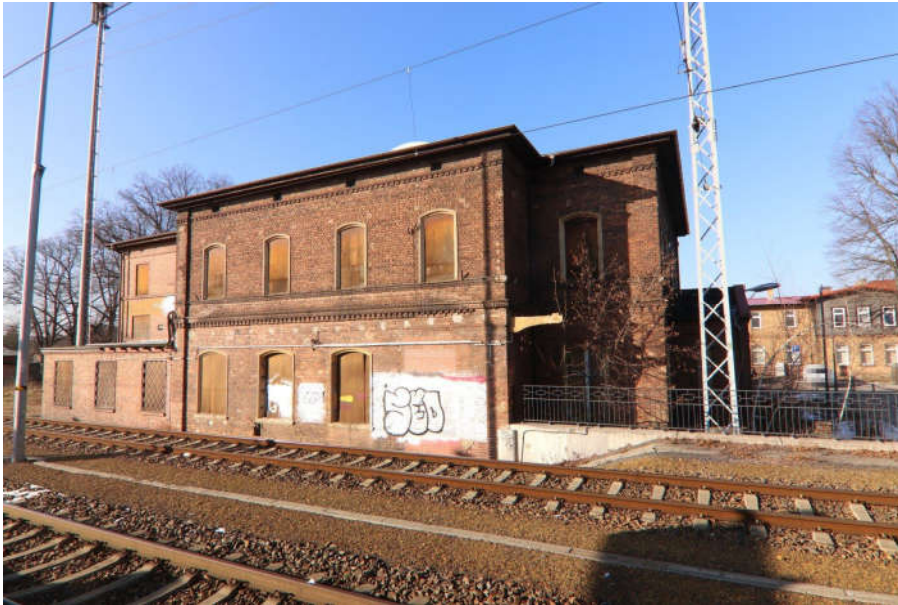
Blick in westliche Richtung von einem Bahnsteig am Bahnhof Ruhland auf das Bahnhofsgebäude (Flurstück 2214).
