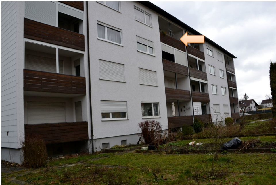
Bild 10: Westansicht 3. Obergeschoss, 2. Balkon von rechts (Bewertungsobjekt Nr. 15)
