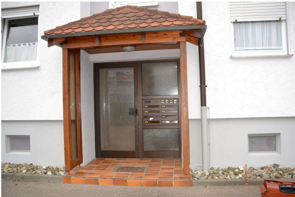
Bild 6: Nordansicht Hauseingang In den Riedwiesen 32
