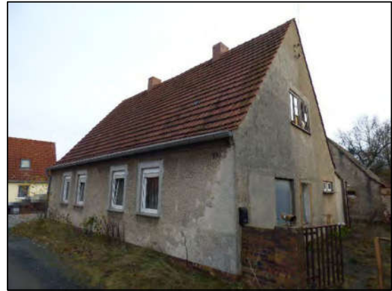
Foto 2: Blick auf Traufseitige Straßenansicht mit Hoftor
