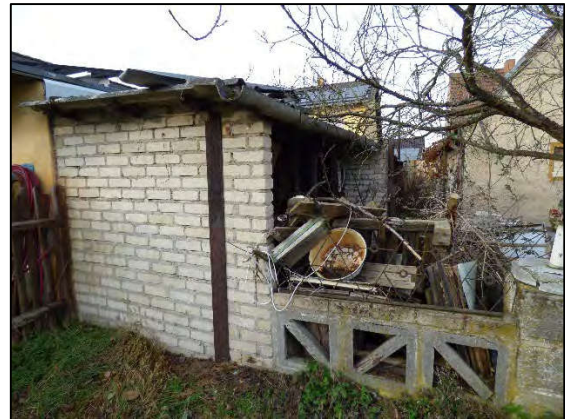
Fotos 4: Unterstände neben Nebengebäude
