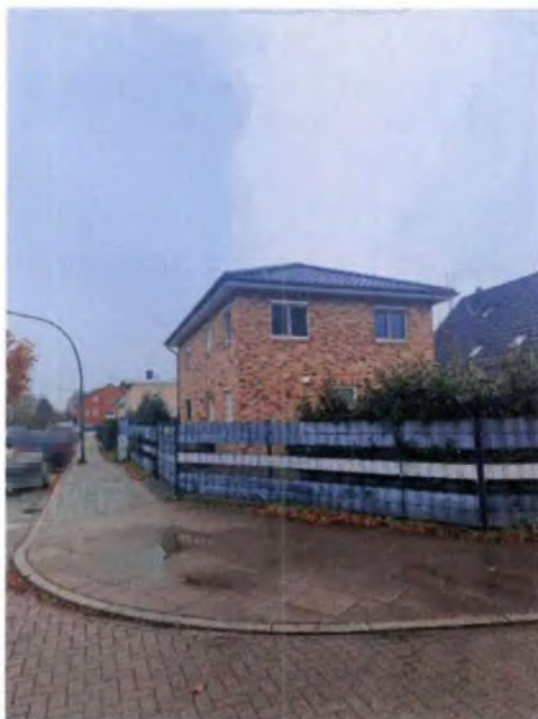
Bild 4: mit Stabgitterzaunanlage (Außenanlagen)
