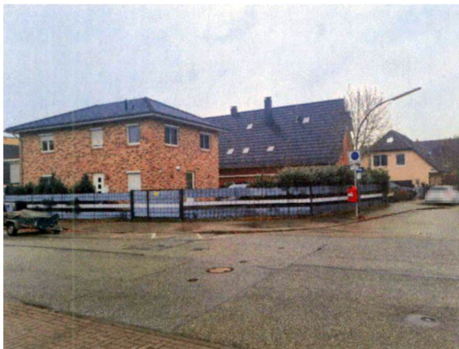
Bild 1: Frontansicht zur Front "Brookdamm"
